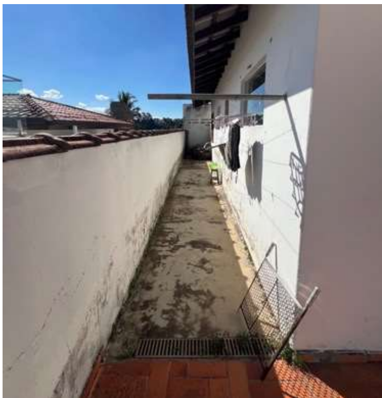
Imagem 48: Corredor lateral da área coberto aos fundos do imóvel
