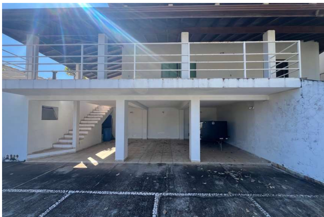
Imagem 04: Garagem coberta para veículos, bem como escada à esquerda para acesso ao imóvel
