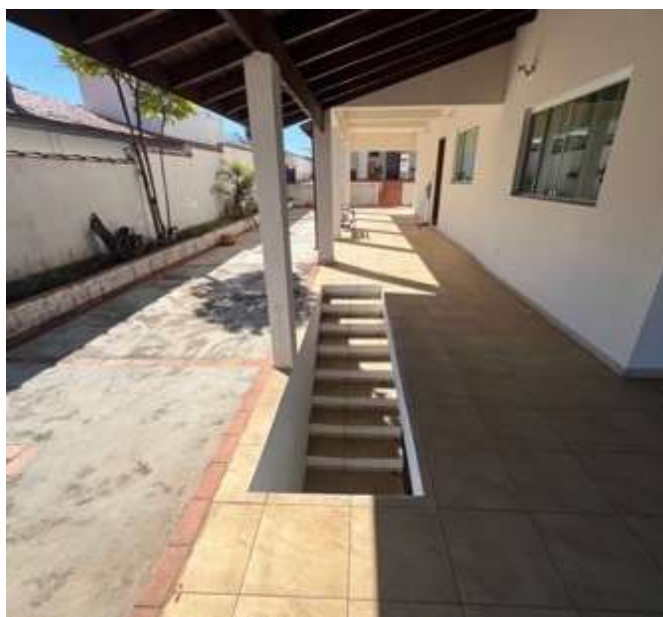
Imagem 38: Escada de acesso a garagem coberto, porta de acesso a cozinha e corredor lateral externo esquerdo, com acesso aos fundos
