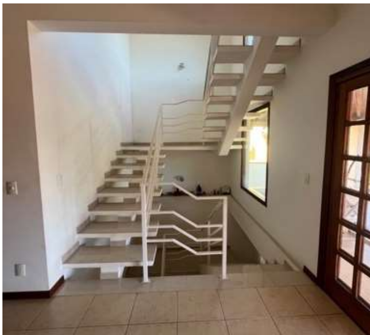
Imagem 29: Escada de acesso para o pav. térreo e para o 2º pav. superior
