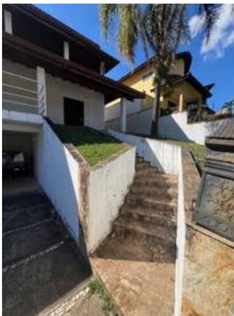
Imagem 05: Escada para acesso a porta principal de entrada do imóvel
