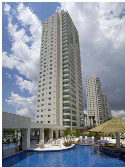
Vista da Fachada do Imóvel Avaliando
