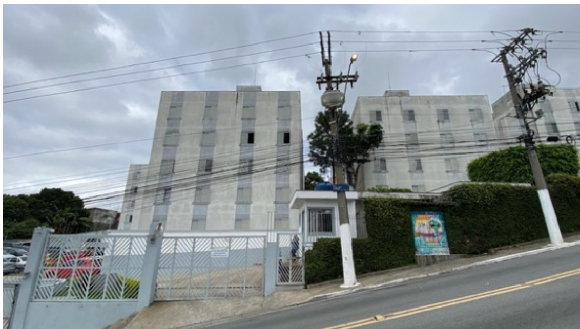
Foto 2 – Vista geral do condomínio e entrada fática pela Rua Dr. José Gravonski
