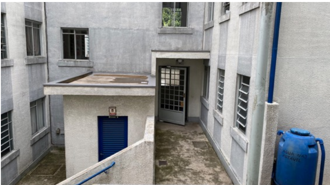
Foto 6 – Entrada do Bloco D
