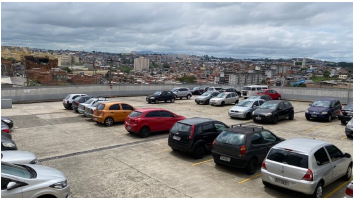
Foto 4 – Estacionamento dos condôminos.
