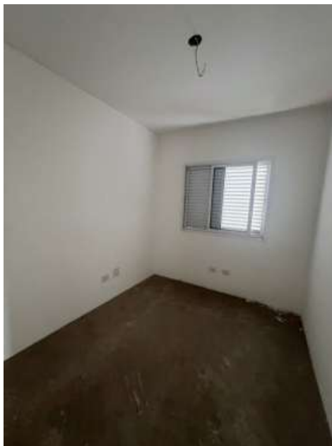
FOTO 14 Vista do primeiro dormitório.
