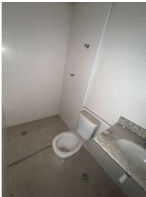
FOTO 12 Vista do banheiro.
