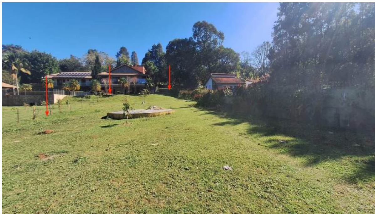
Foto 17 – Porção posterior do imóvel – setas indicam divisa com Cond. Patrimônio do Carmo
