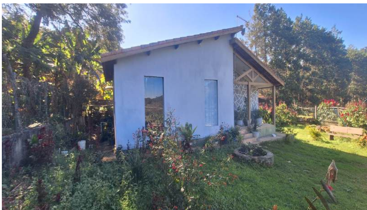
Foto 18 – Casa situada na porção posterior do imóvel, junto à divisa – residência do Sr. Walter
