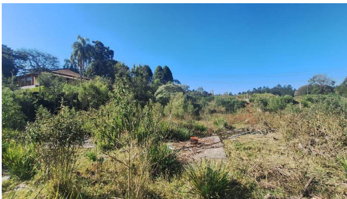
Foto 6 – Área demolida – antigo heliponto – à esquerda, casa em propriedade vizinha
