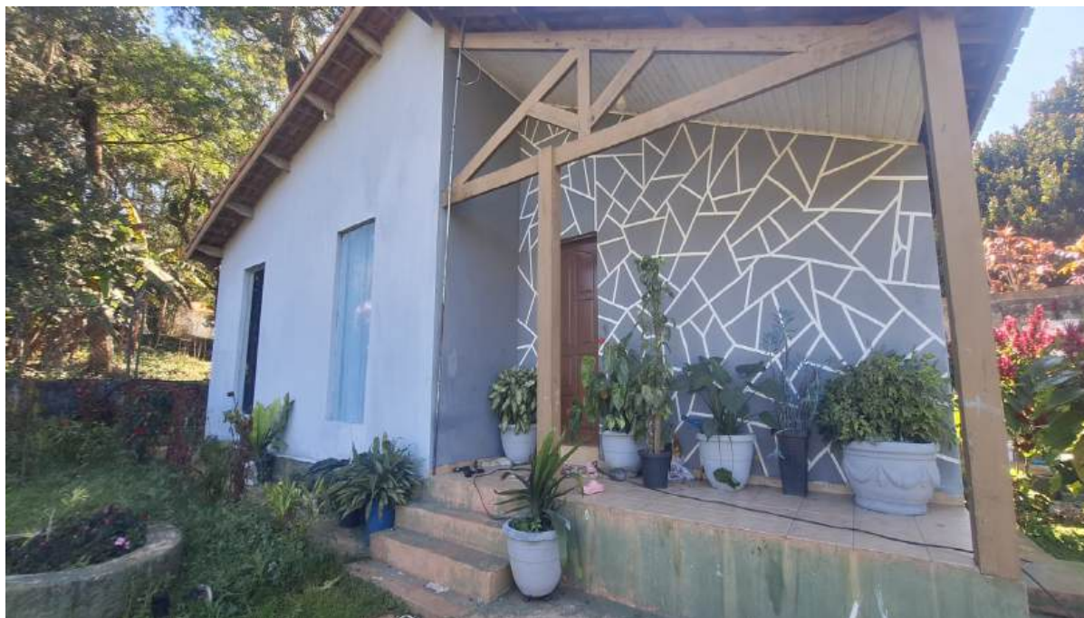
Foto 19 – Casa situada na porção posterior do imóvel, junto à divisa – residência do Sr. Walter
