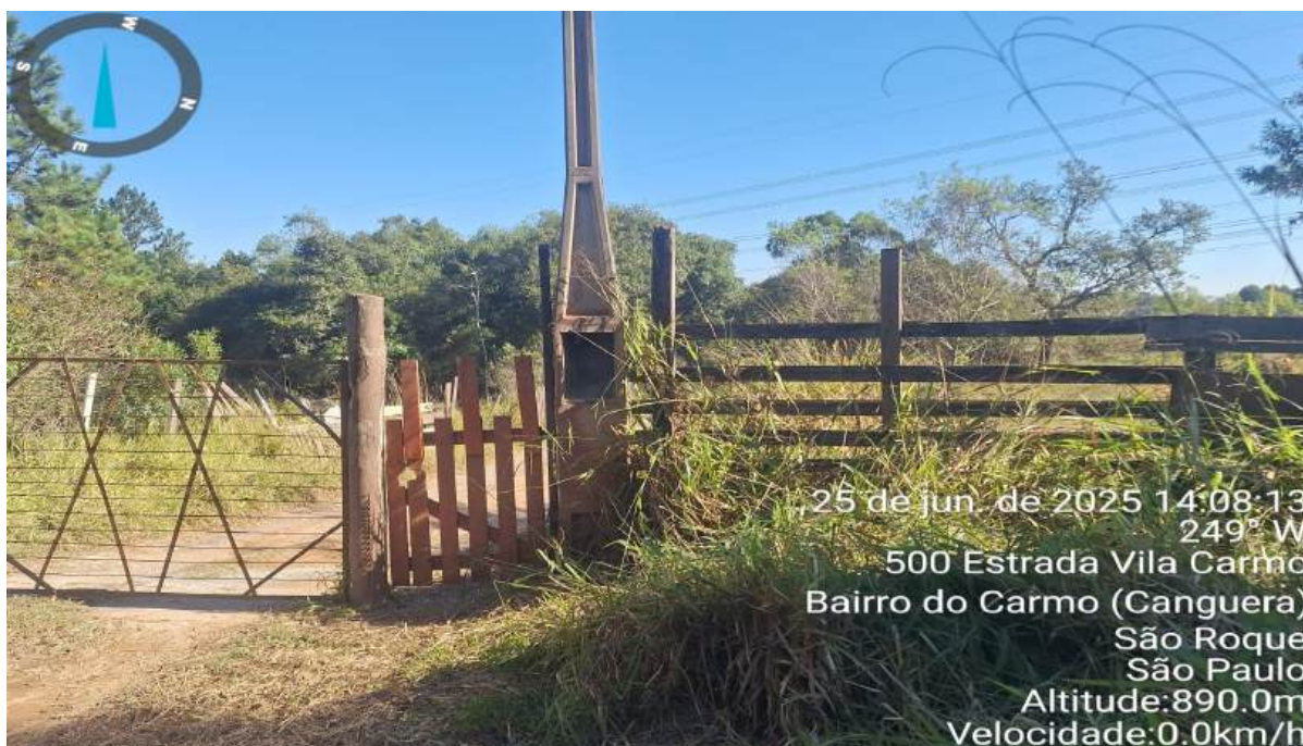
Foto 1 – Porteira de acesso ao imóvel (Estrada do Carmo, 517)
