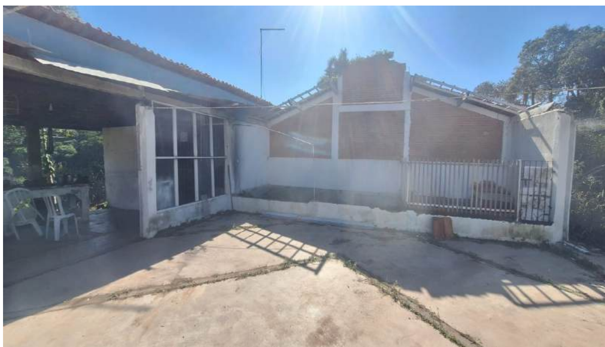
Foto 8 – Antigo espaço do restaurante (demolido) – à esquerda o barracão/depósito
