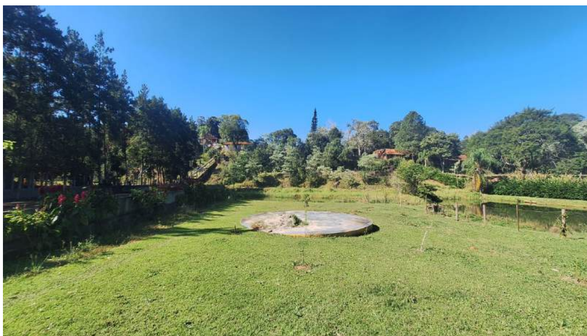
Foto 16 – Porção posterior do imóvel – ao centro, heliponto desativado
