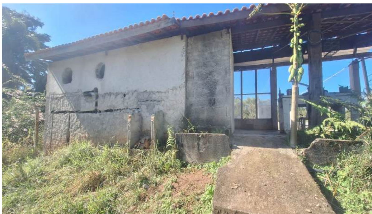
Foto 10 – Barracão/depósito de ferramentas visto pelo caminho de acesso à parte posterior
