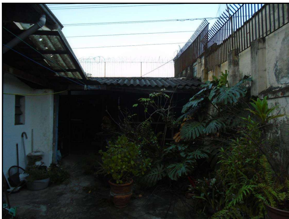
FOTO Nº06: ASPECTO DA COBERTURA NOS FUNDOS.
