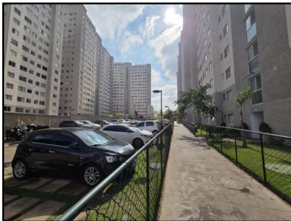
4. Vista interna do condomínio.
