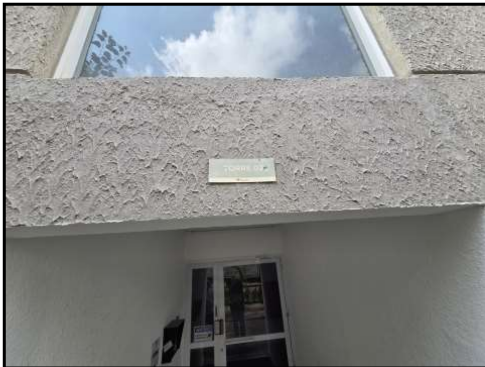
10. Identificação da Torre 02.
