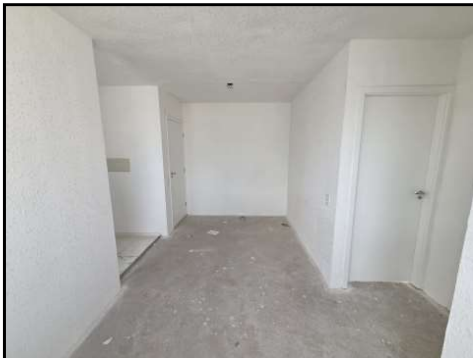
16. Vista interna da saa no sentido da cozinha, banheiro e dormitórios.
