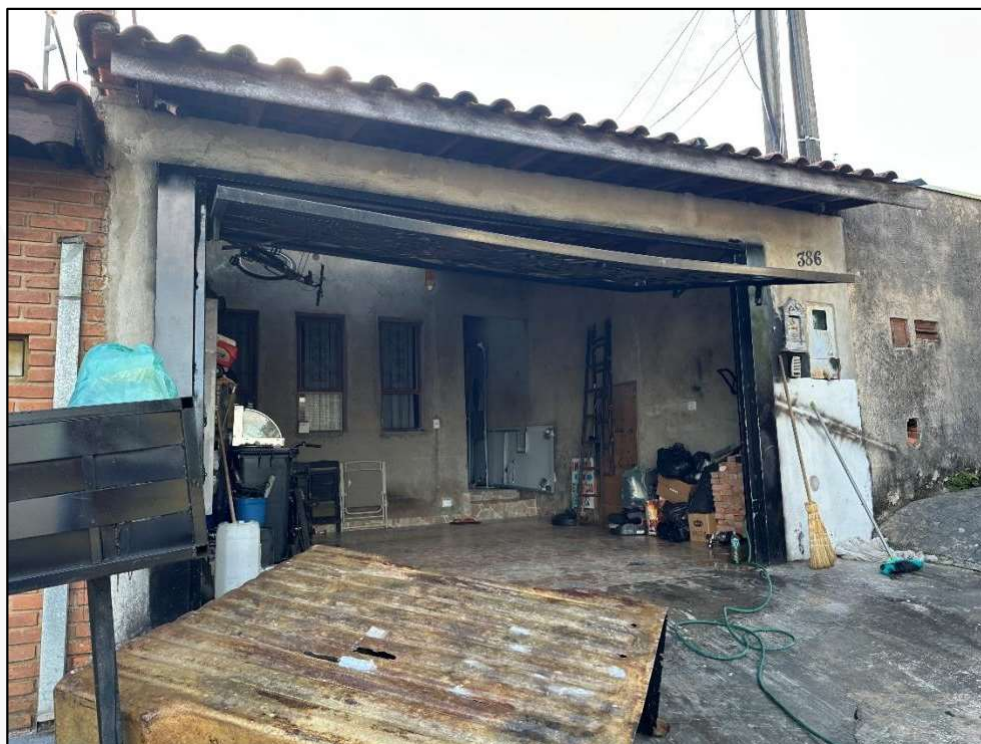
Foto 1 – Vista frontal de acesso ao imóvel.
