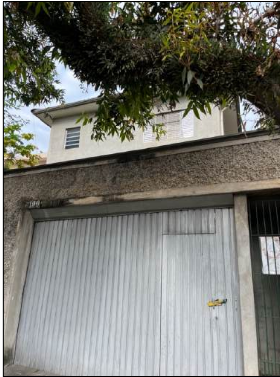
Foto 01 – Frente do imóvel
