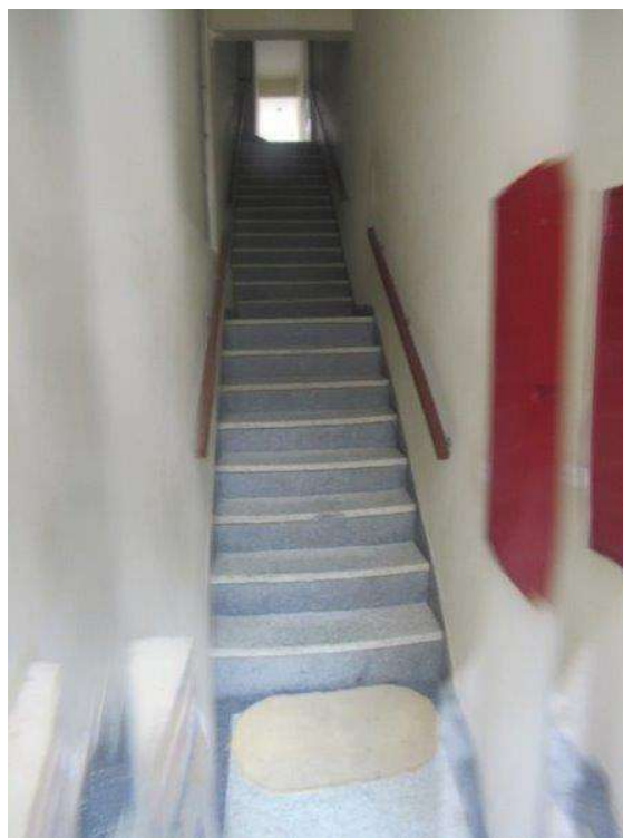
Escada de Acesso
