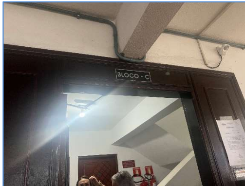
Foto 9 – Vista da entrada Bloco C
