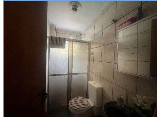
Foto 4 – Vista do banheiro
