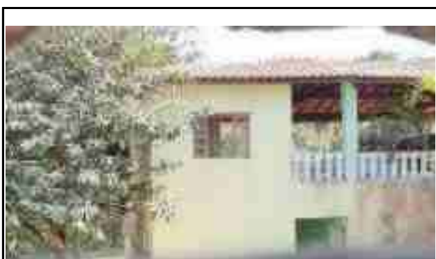
Vista da construção, tirada do portão de acesso
