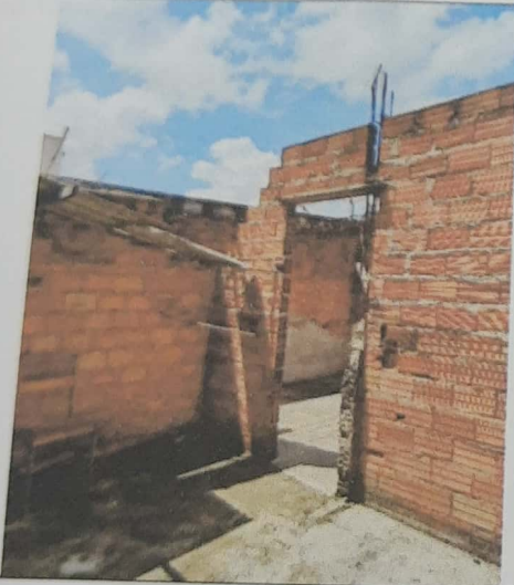
24. Pavimento Superior (Construção Iniciada)
