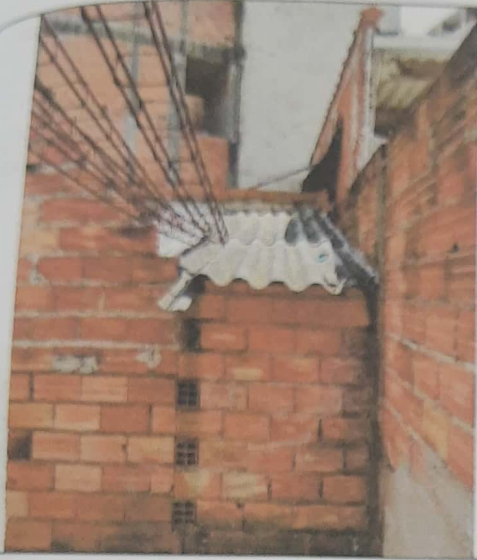
22. Pavimento Superior (Construção Iniciada)
