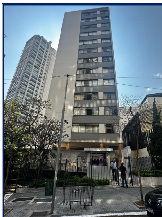
Vista panorâmica do Edifício Inajá
