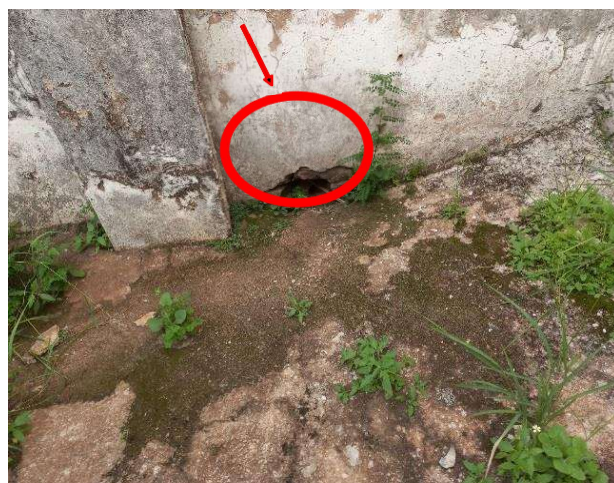
Vista parcial do dreno de aguas pluviais
