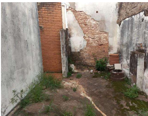
Vista do estado de conservação dos fundos
