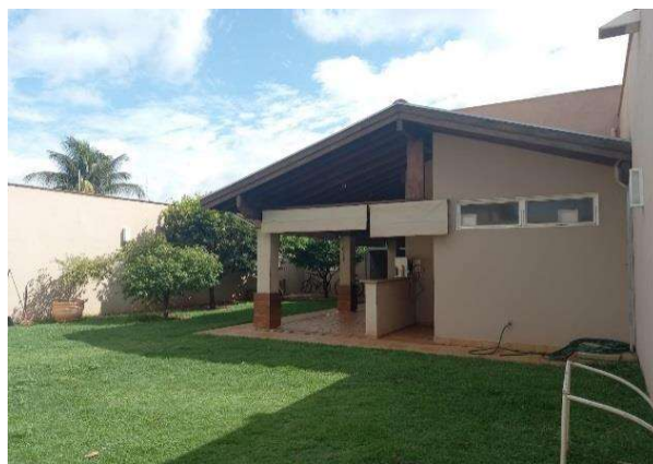
Vista sob outro ângulo dos fundos da edificação
