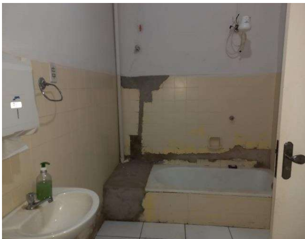
Vista parcial do banheiro e pia
