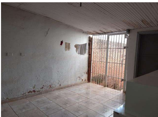
Vista do portão da escada do corredor
