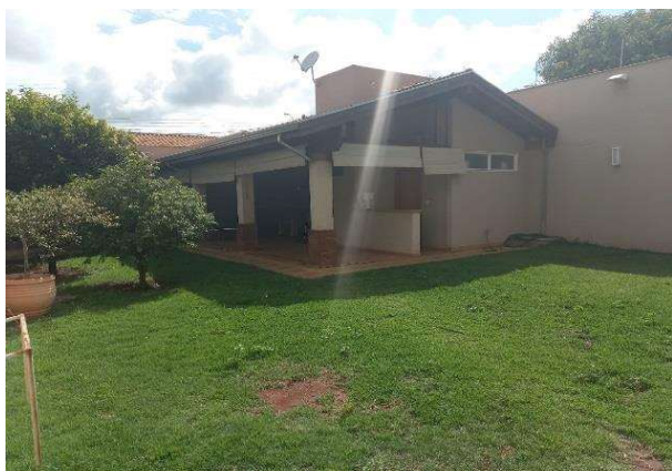
Vista da edificação e área do fundo
