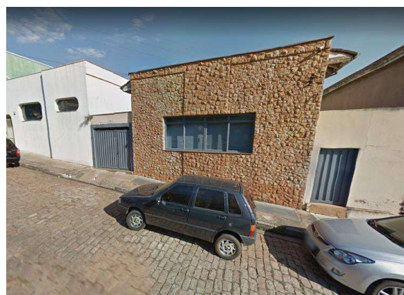
Vista parcial da fachada do imóvel principal
