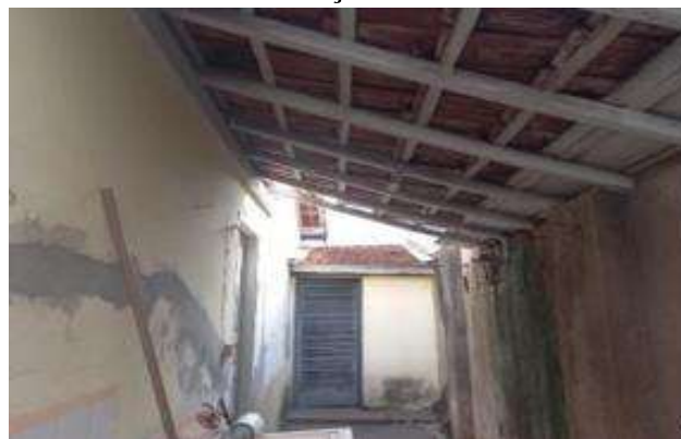
Vista da área de serviço da casa dos fundos.
