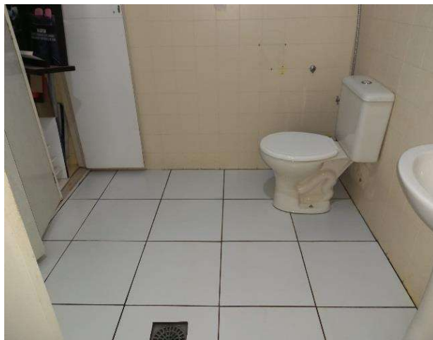
Vista parcial do banheiro, piso e porta
