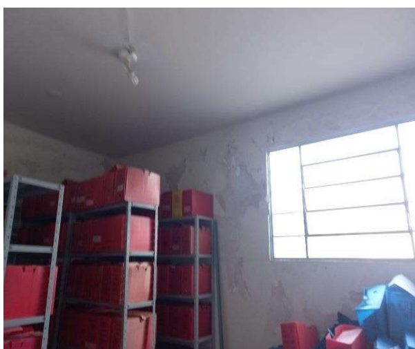
Vista parcial da janela e estado de uso
