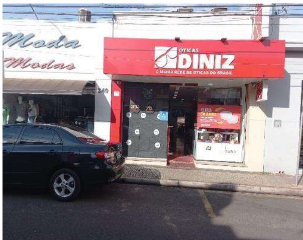
Vista parcial da fachada do imóvel
