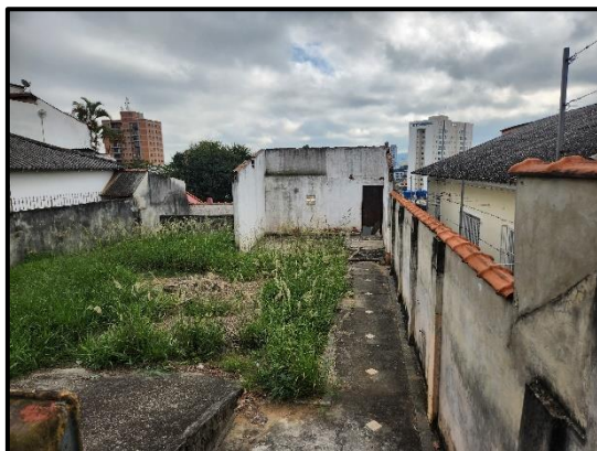
Vista geral do imóvel. É possível notar a edificação demolida
