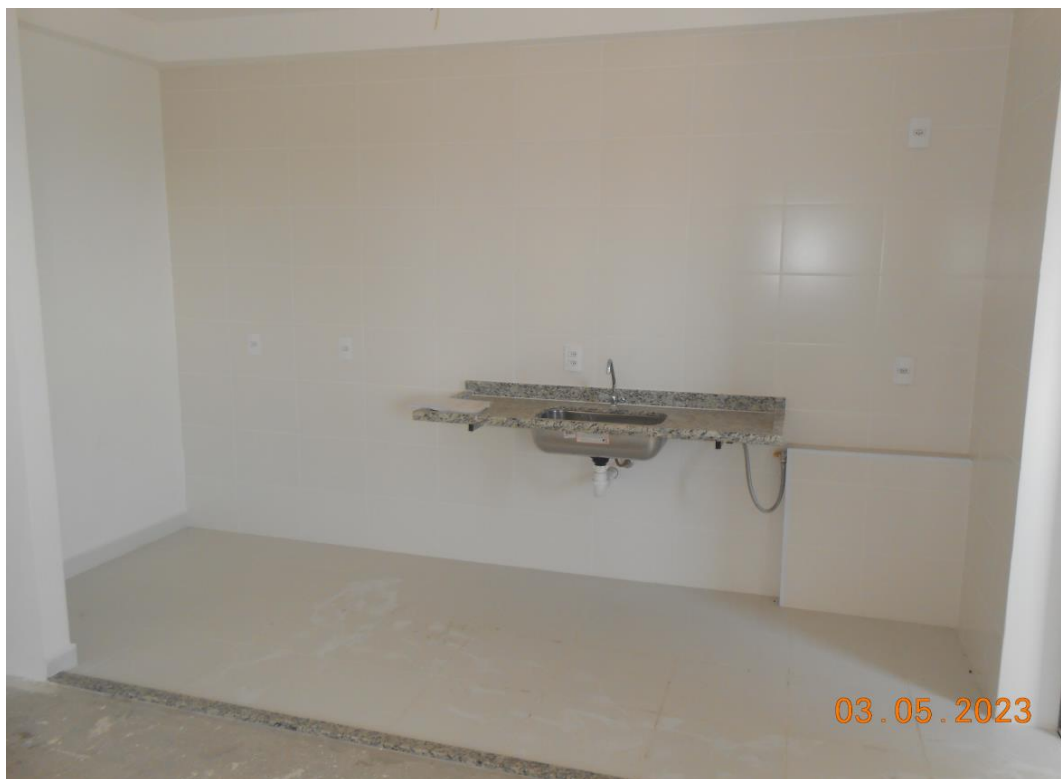
Foto 4: Vista da cozinha.
