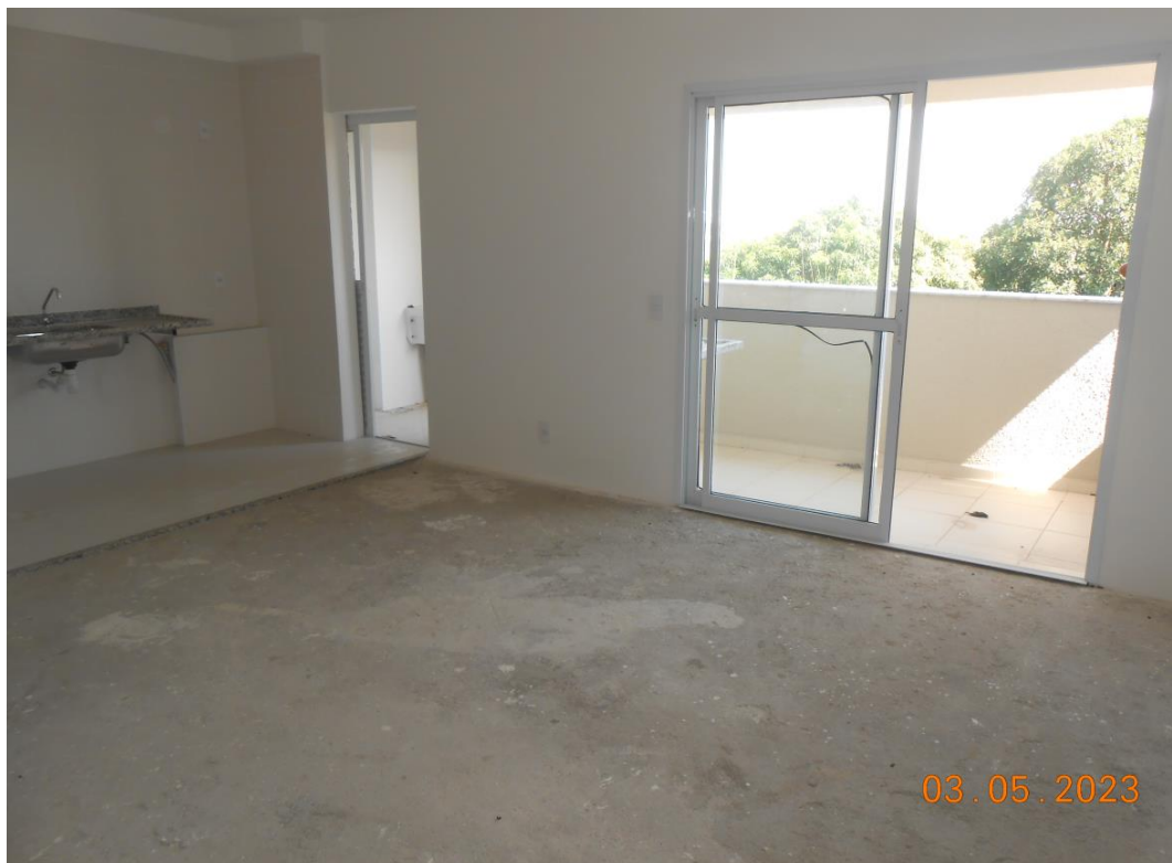
Foto 5: Vista da sala de estar.
