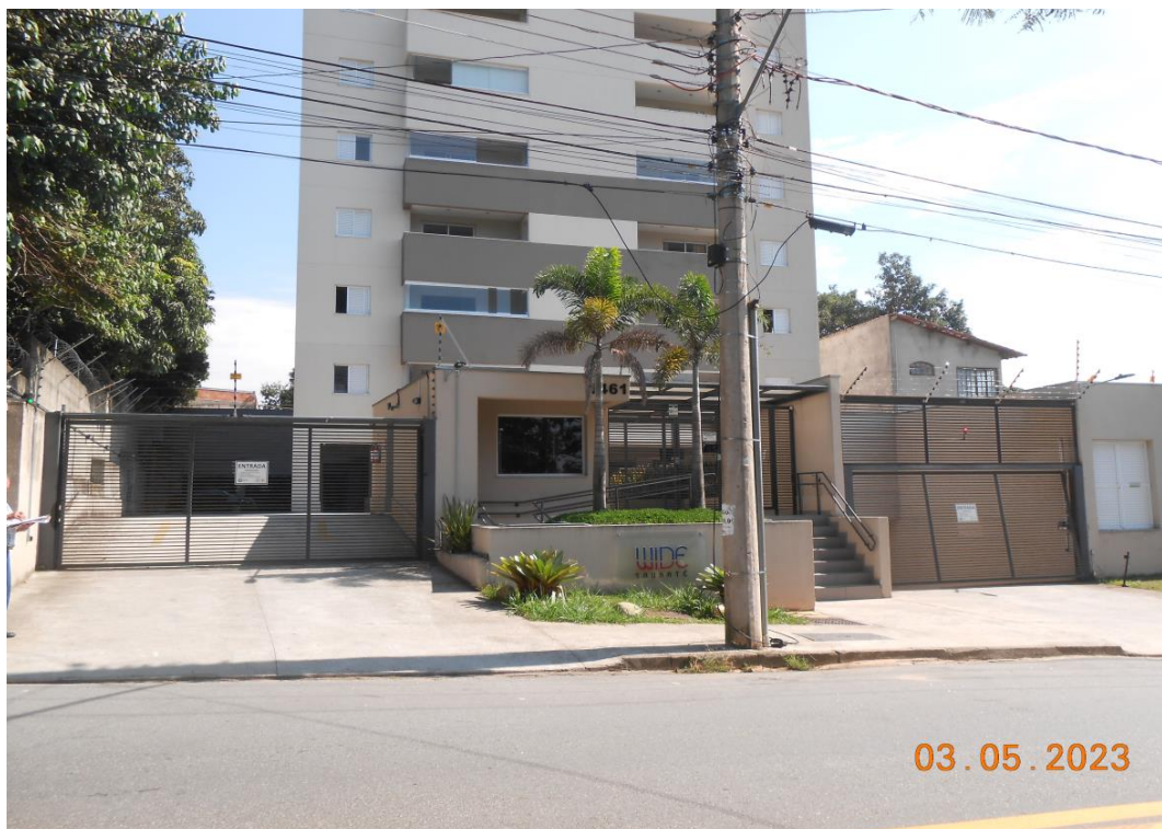
Foto 1: Vista frontal do Edifício Wide Taubaté.
