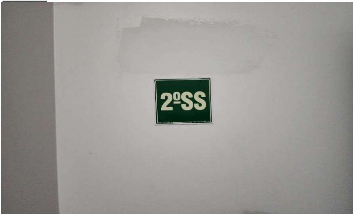
VISTA DO CONDOMÍNIO EDIFÍCIO RESIDENCIAL TOULOUSSE, ACESSO AO SUBSOLO.
