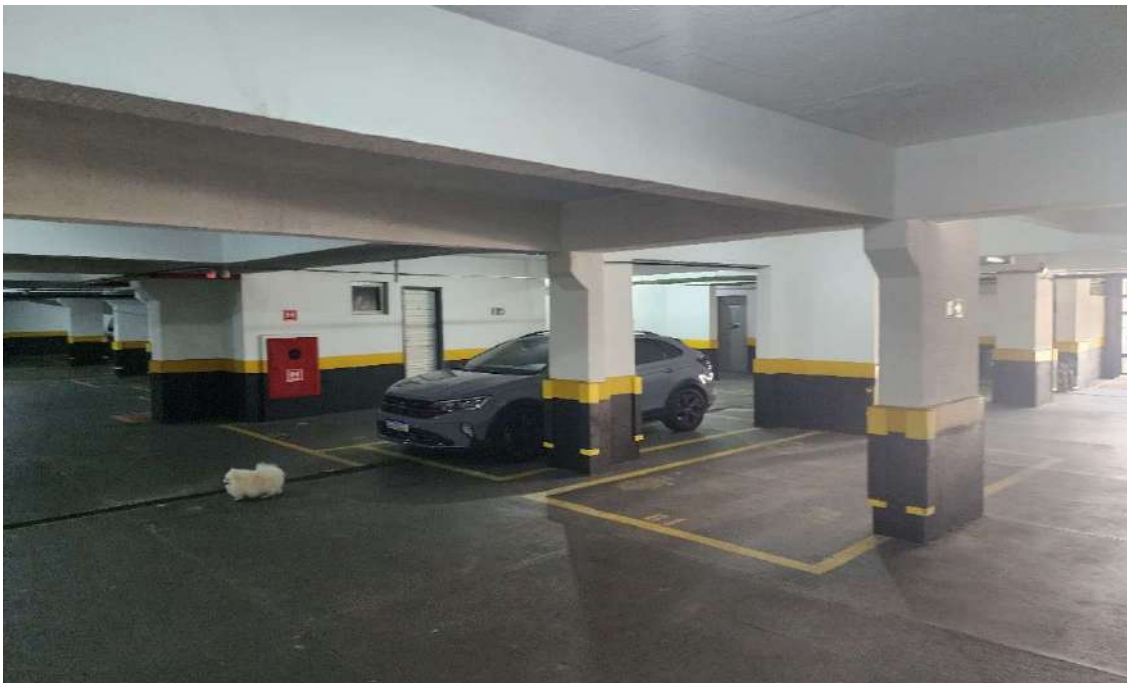
VISTA DA VAGA DA GARAGEM DO AP 31 - EDIFÍCIO RESIDENCIAL TOULOUSSE.
