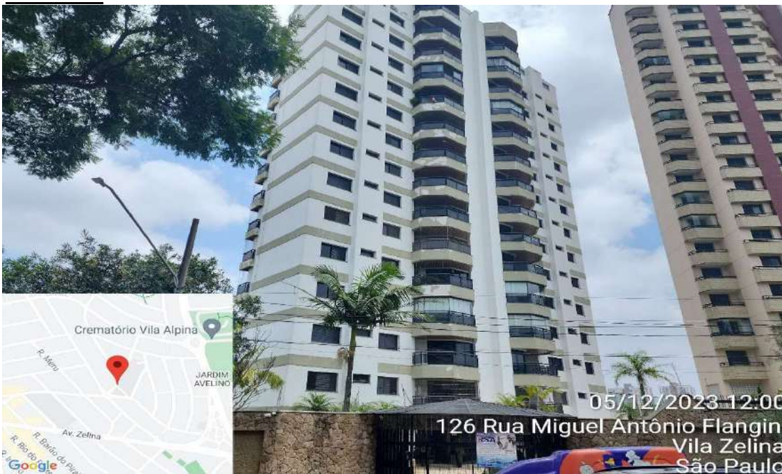
VISTA DO CONDOMÍNIO EDIFÍCIO RESIDENCIAL TOULOUSE.
