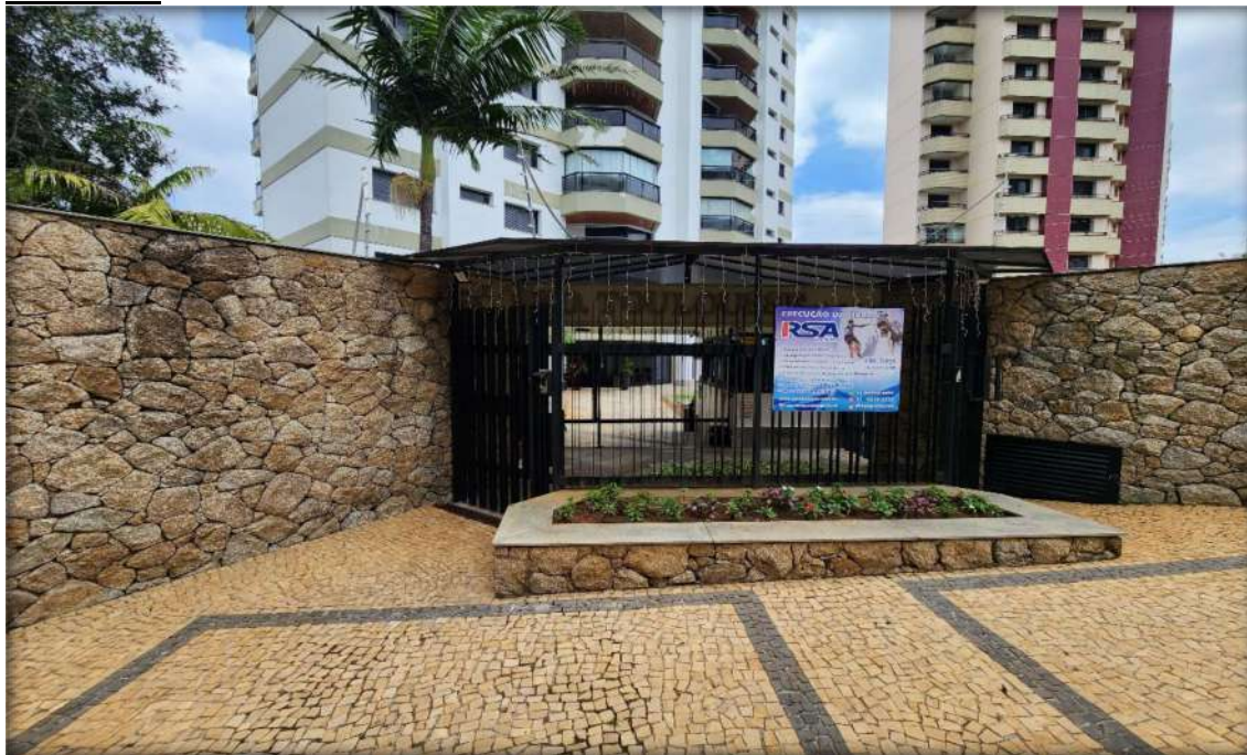
VISTA DA FACHADA DO CONDOMÍNIO EDIFÍCIO RESIDENCIAL TOULOUSE.
