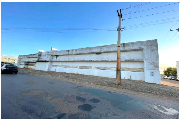
Fachada para a Rua Rio de Janeiro
