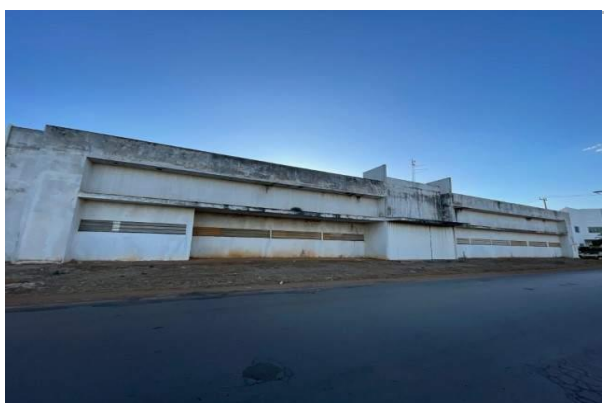
Fachada para a Rua Rio de Janeiro
