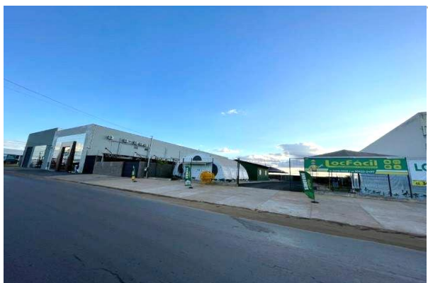
Imóvel vizinho lateral esquerda
