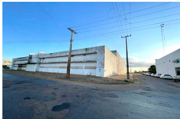
Fachada para a Rua Rio de Janeiro
