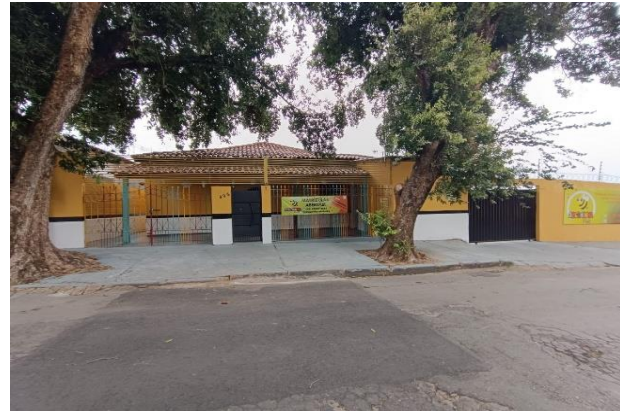
Vista da escola localizada à esquerda do terreno
