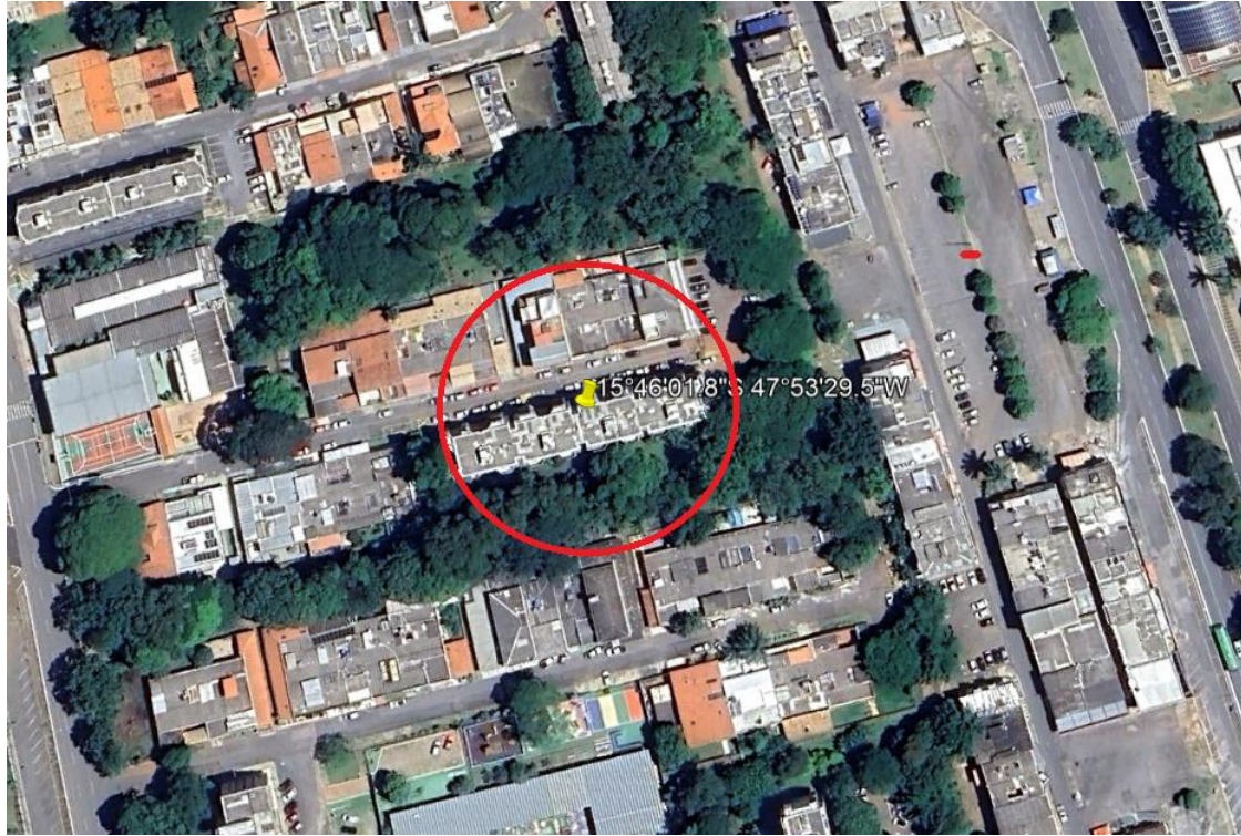
Situação em fevereiro de 2024
