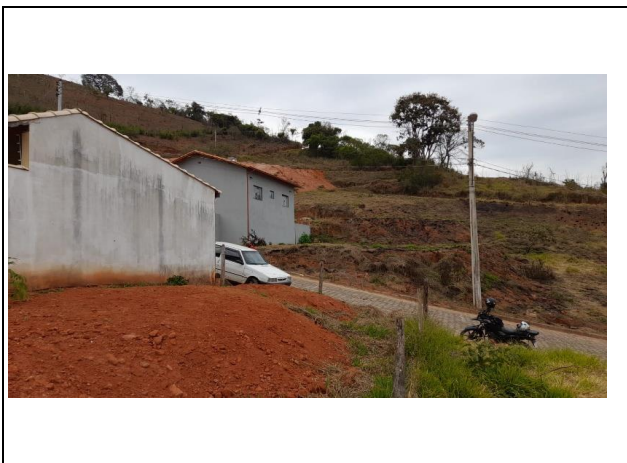
VISTA DO TERRENO
