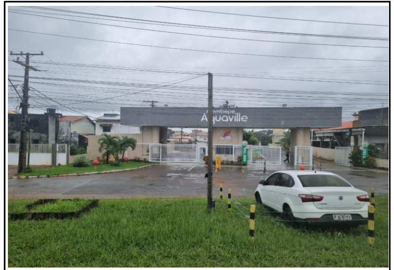
VISTA DA FACHADA / PORTARIA
