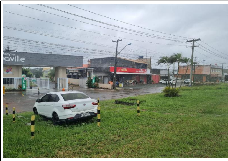
VISTA DA FACHADA / PORTARIA
