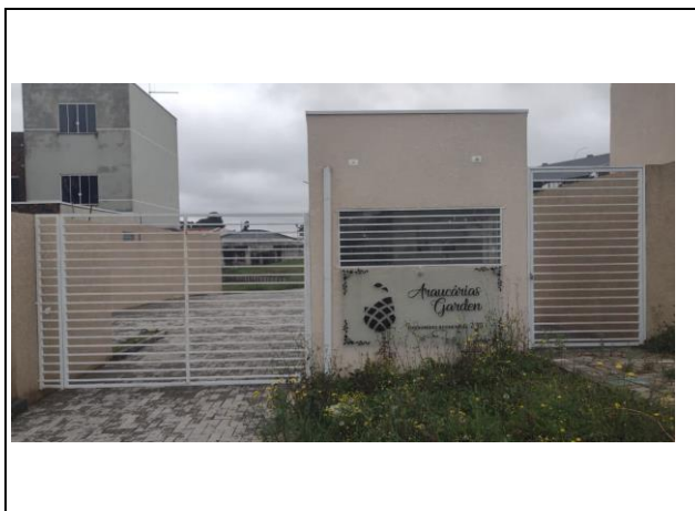
VISTA DA FACHADA / PORTARIA
