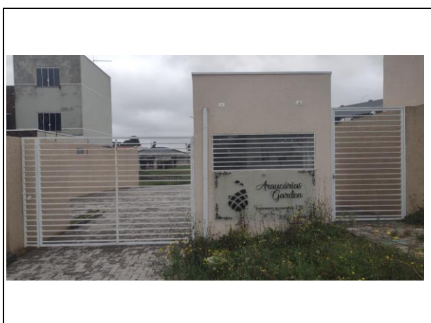
VISTA DA FACHADA / PORTARIA
