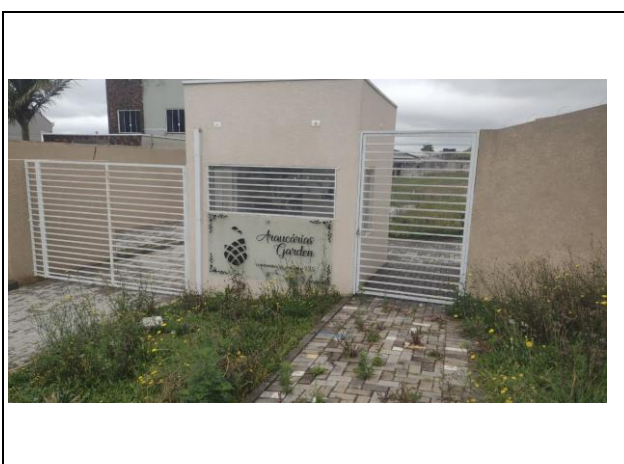
VISTA DA FACHADA / PORTARIA
