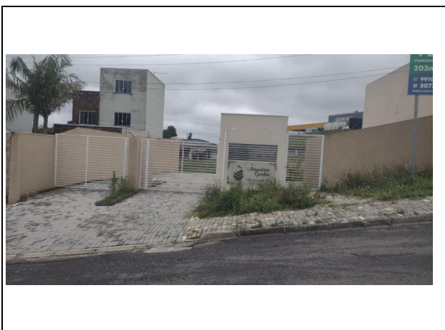
VISTA DA FACHADA / PORTARIA
