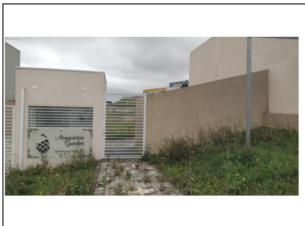
VISTA DA FACHADA / PORTARIA
