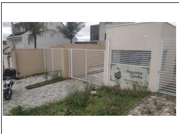
VISTA DA FACHADA / PORTARIA
