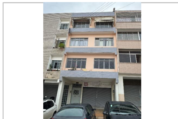
Vista da frente para o Bloco 1625
