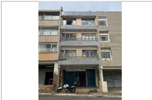
Vista da frente para o Bloco 1645
