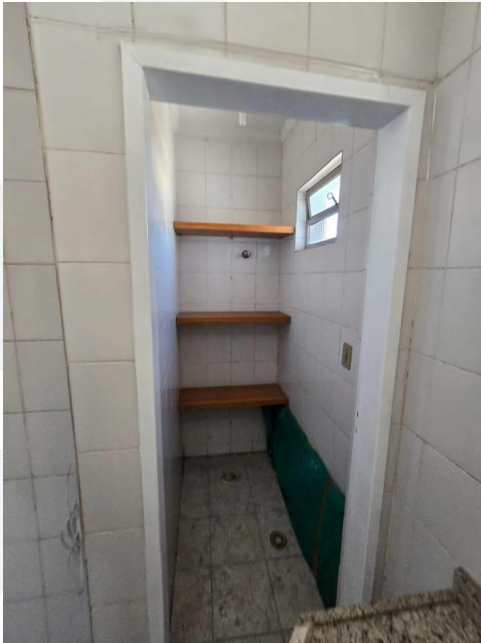
Foto 39 - Vista Interna do Imóvel
