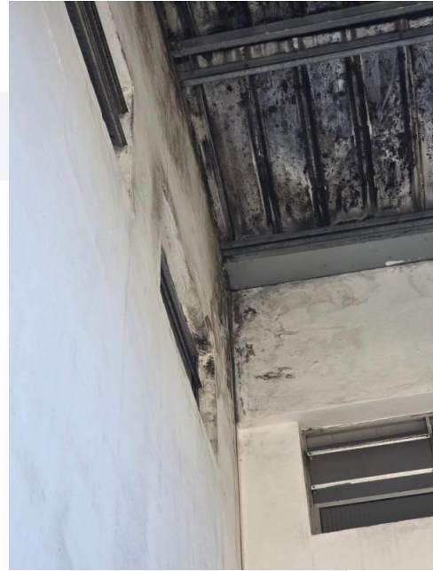
Foto 26 – Vista Interna do Imóvel
