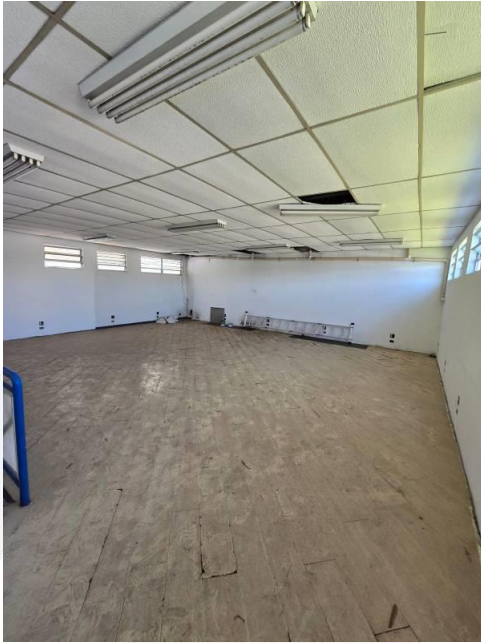
Foto 49 - Vista Interna do Imóvel
