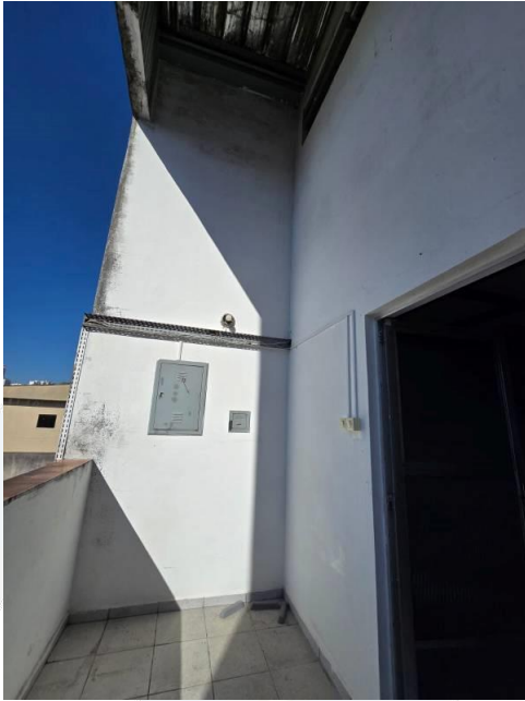
Foto 29 - Vista Interna do Imóvel
