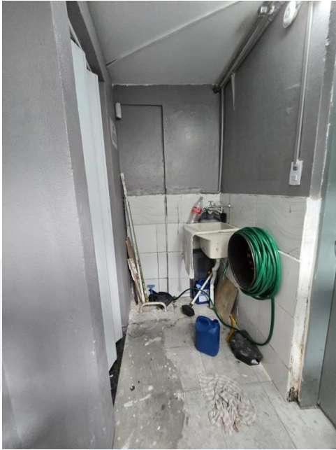
Foto 1 - Vista Interna do Imóvel
