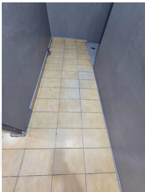
Foto 13 - Vista Interna do Imóvel
