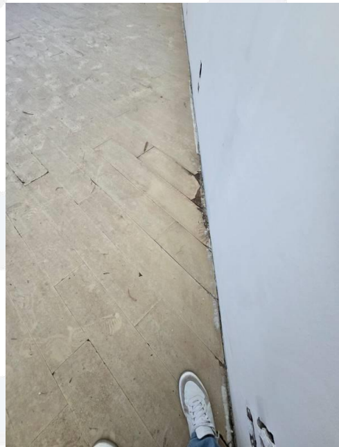
Foto 48 - Vista Interna do Imóvel
