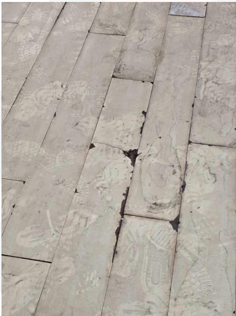
Foto 43 - Vista Interna do Imóvel
