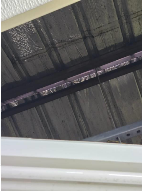
Foto 45 - Vista Interna do Imóvel
