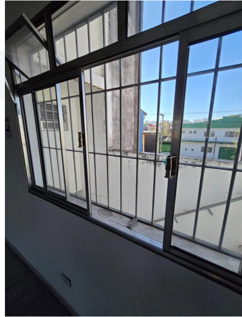
Foto 30 - Vista Interna do Imóvel
