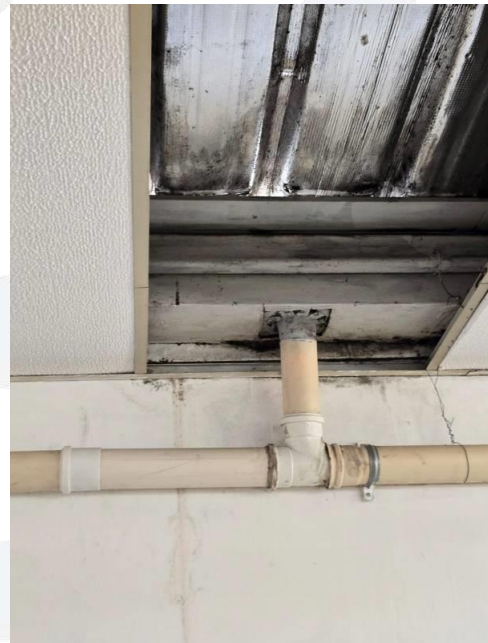
Foto 44 - Vista Interna do Imóvel
