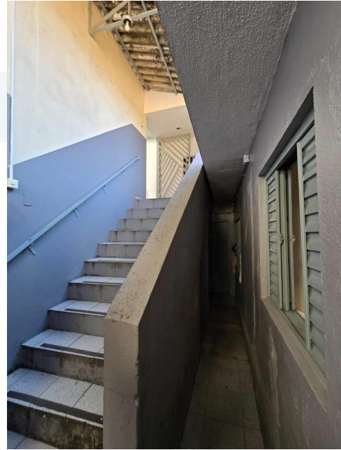
Foto 18 - Vista Interna do Imóvel
