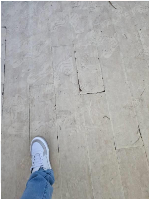
Foto 47 - Vista Interna do Imóvel
