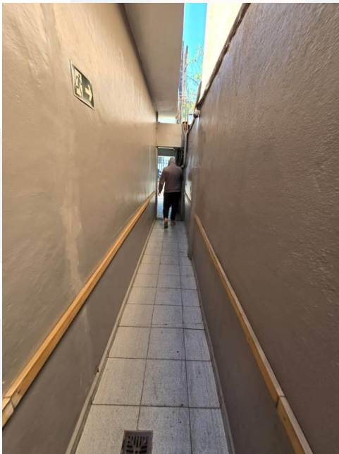
Foto 19 - Vista Interna do Imóvel
