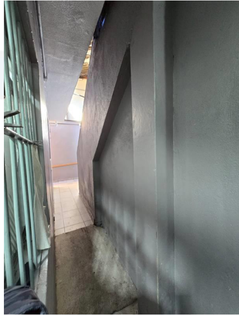
Foto 2 - Vista Interna do Imóvel
