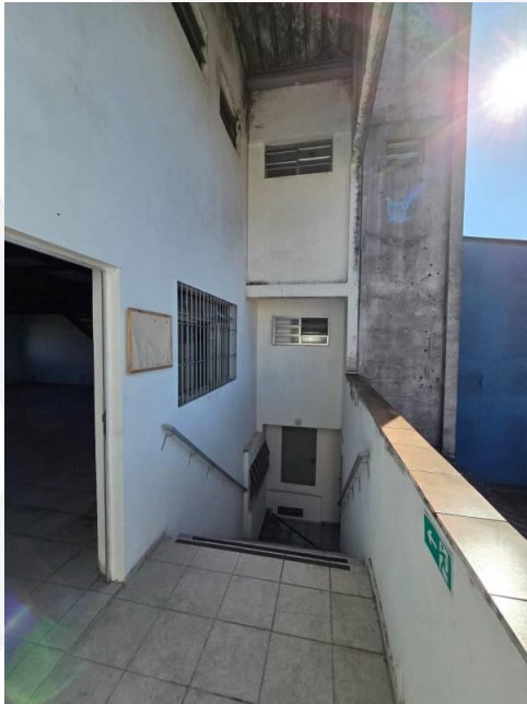
Foto 27 – Vista Interna do Imóvel
