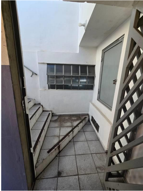
Foto 21 - Vista Interna do Imóvel
