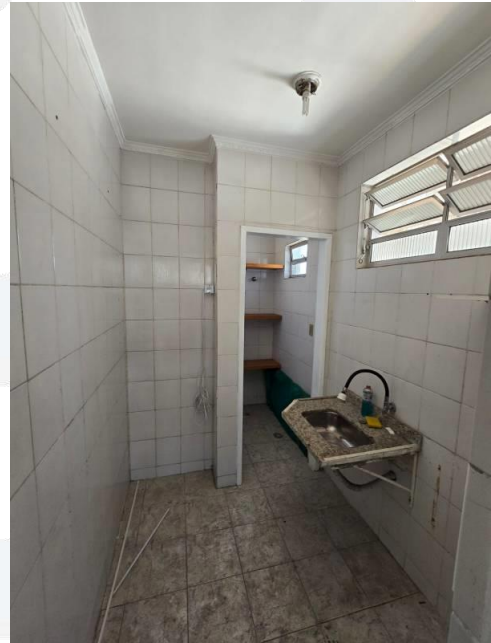
Foto 40 - Vista Interna do Imóvel
