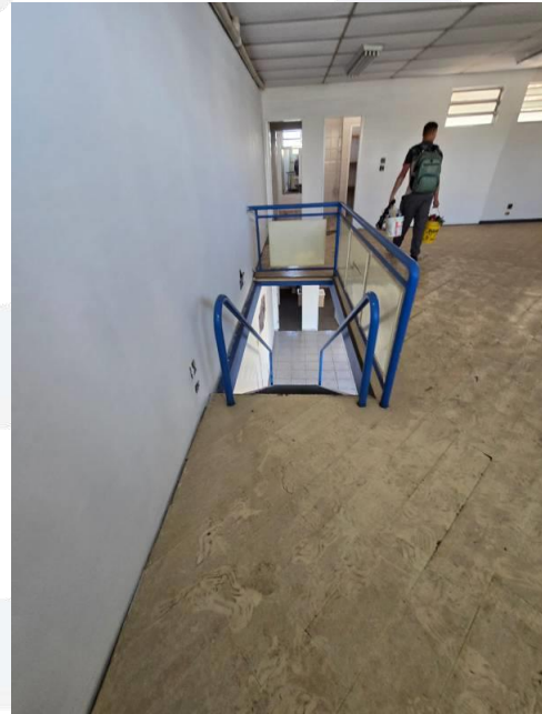
Foto 36 - Vista Interna do Imóvel
