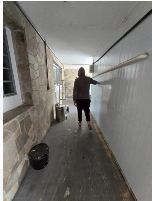
Foto 20 - Vista Interna do Imóvel
