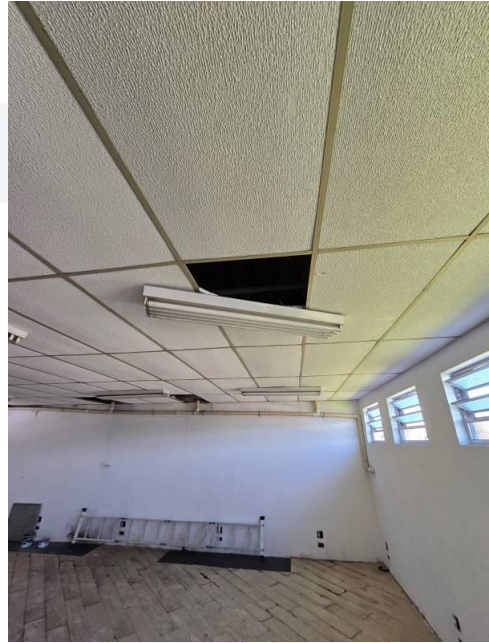
Foto 46 - Vista Interna do Imóvel
