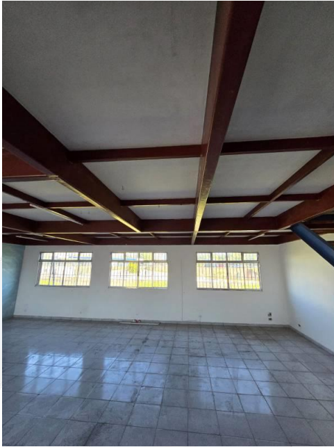
Foto 33 - Vista Interna do Imóvel
