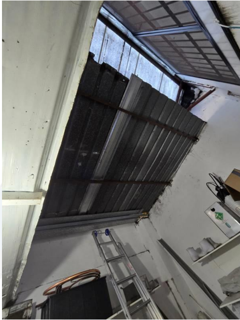
Foto 5 - Vista Interna do Imóvel
