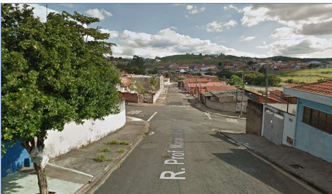
Figure 5 - Melhoramentos Urbanos (Fonte: Google Maps)
