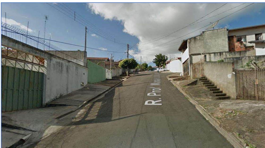
Figure 4 - Melhoramentos Urbanos (Fonte: Google Maps)
