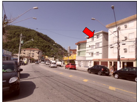
Foto 2 – Av. Prefeito José Monteiro na quadra onde se localiza o prédio do apartamento avaliado
