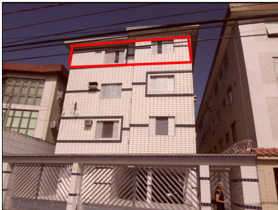
Foto 1 – Vista frontal do Edifício Costa Branca onde se situa o apartamento avaliado no 3º andar indicado na foto
