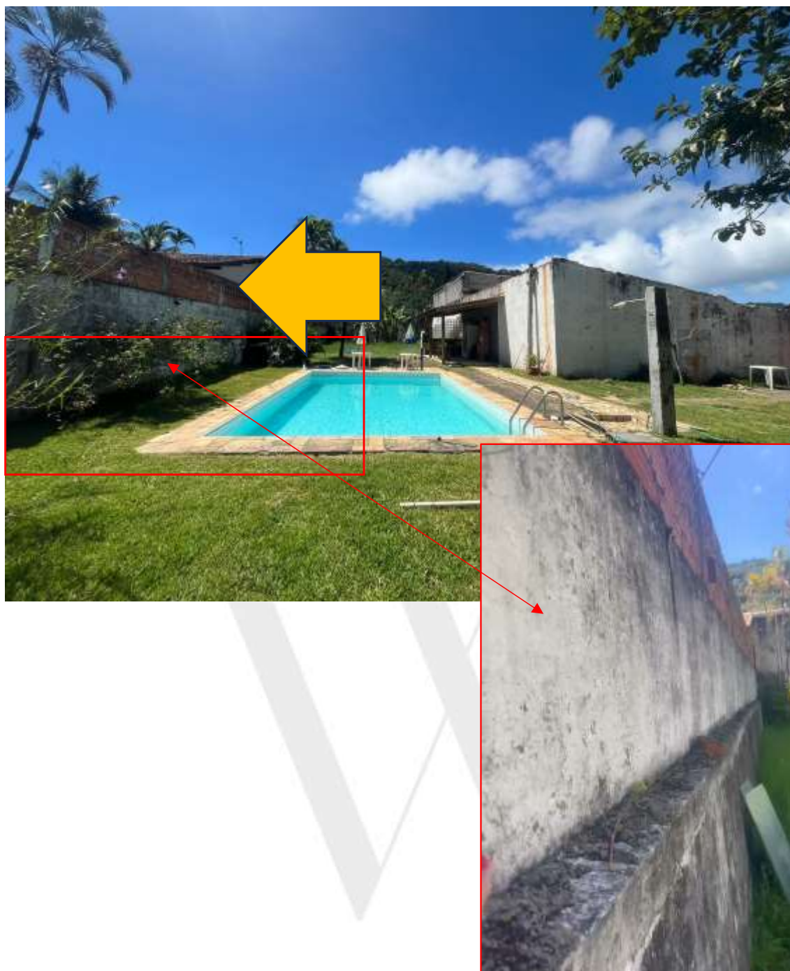
Foto 19 – Vista geral do muro baixo de divisa, conforme marcação em vermelho, localizado na lateral esquerda de quem olha para o terreno.
