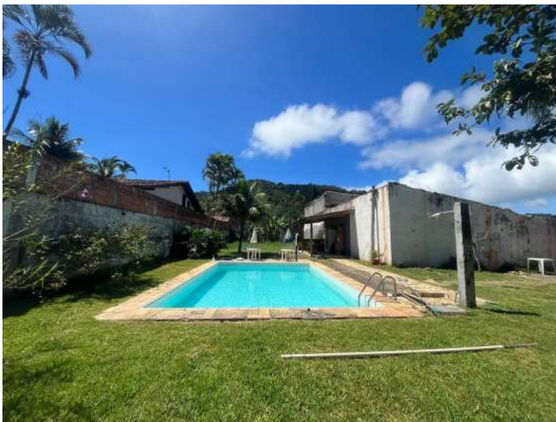
Foto 8 – Vista geral do terreno com construções clandestinas e obsoletas.
