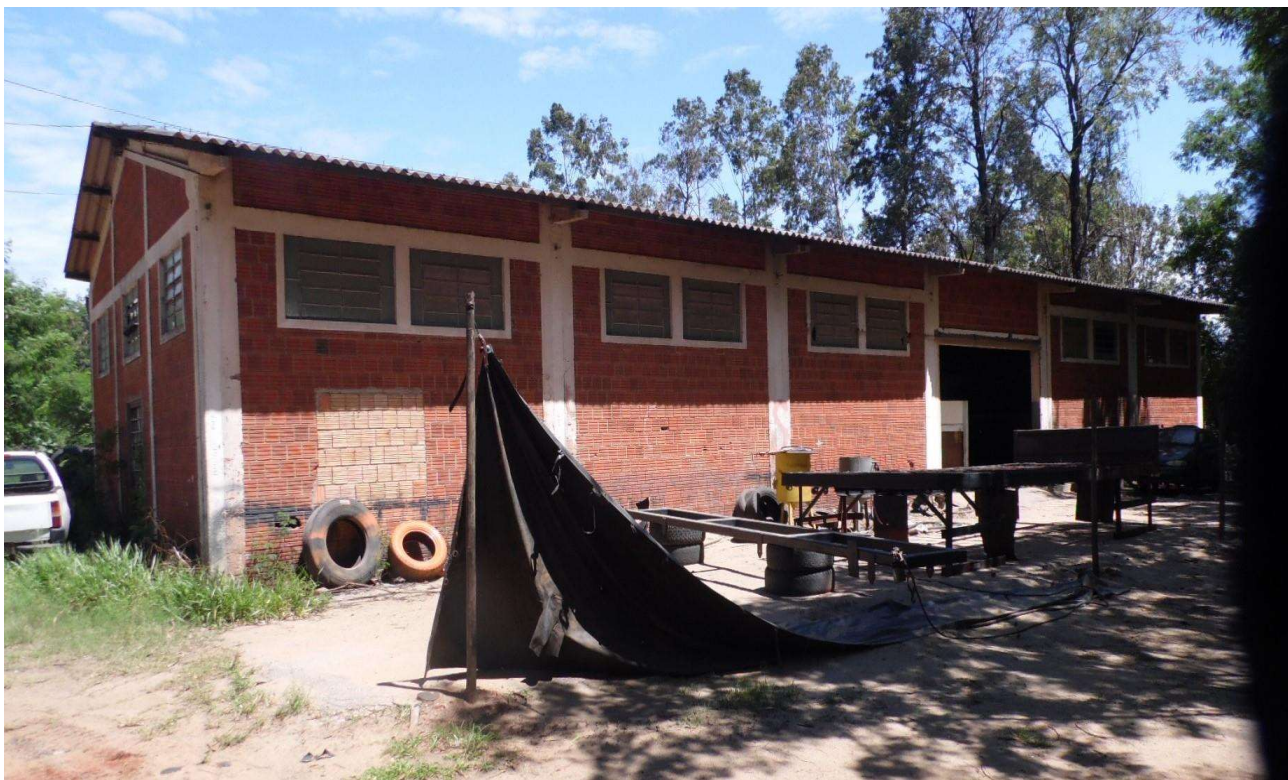
Imagem 22 – Outra Empresa instalada no local trabalha com jateamento de areia e utilizada o Galpão/Barracão acima, que possui uma área construída aproximada de 270.00 m2, no entanto, por também estar negligenciado em relação a conservação/manutenção possui valor reduzido.
