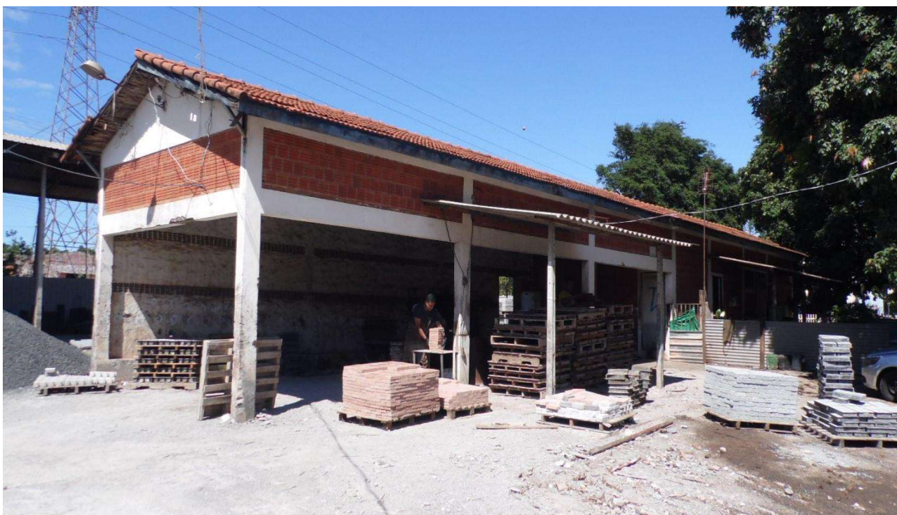
Imagem 13 – Galpão de trabalho - área construída aproximada de 120.00 m2, construção antiga e negligenciada em relação a conservação/manutenção, o que reduz o seu valor de mercado.
