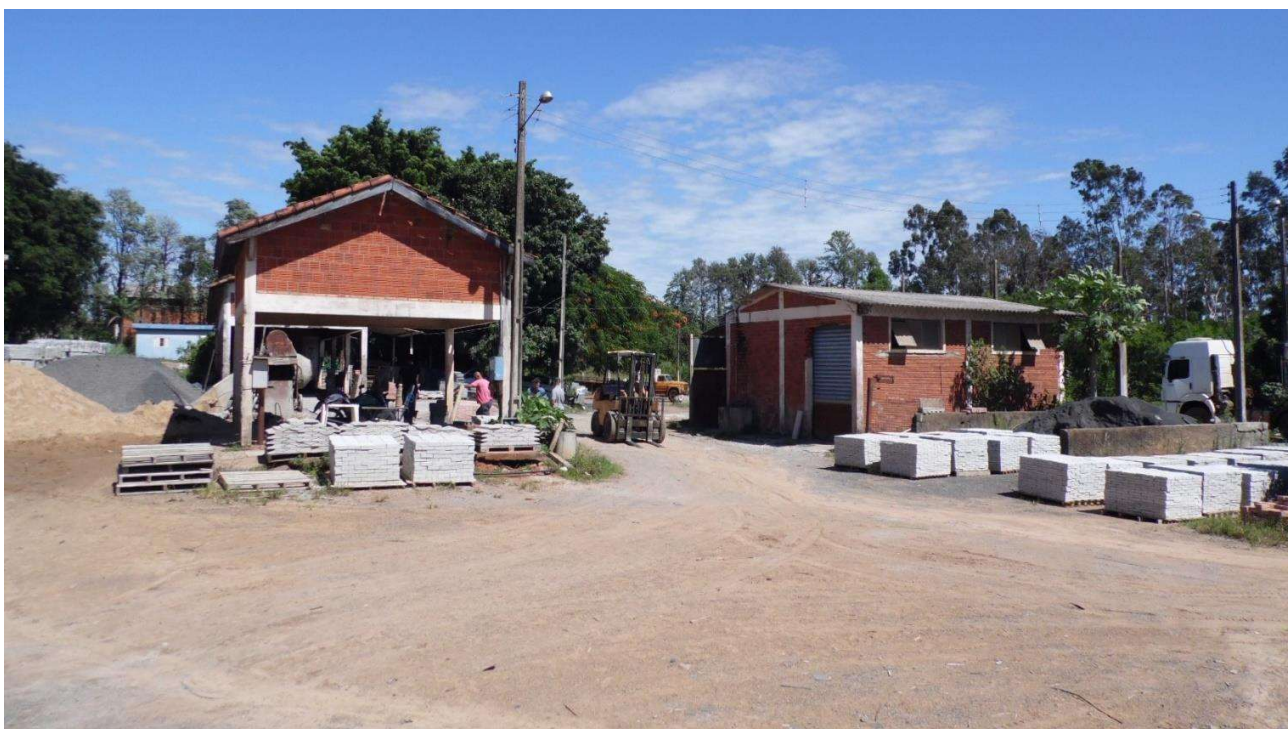
Imagem 05 – Uma das Empresas instaladas no local é a Empresa do Sr. Maurício Bazoti que fabrica pisos de concreto, a qual está utilizando a maioria dos Galpões/Barracões existentes.
