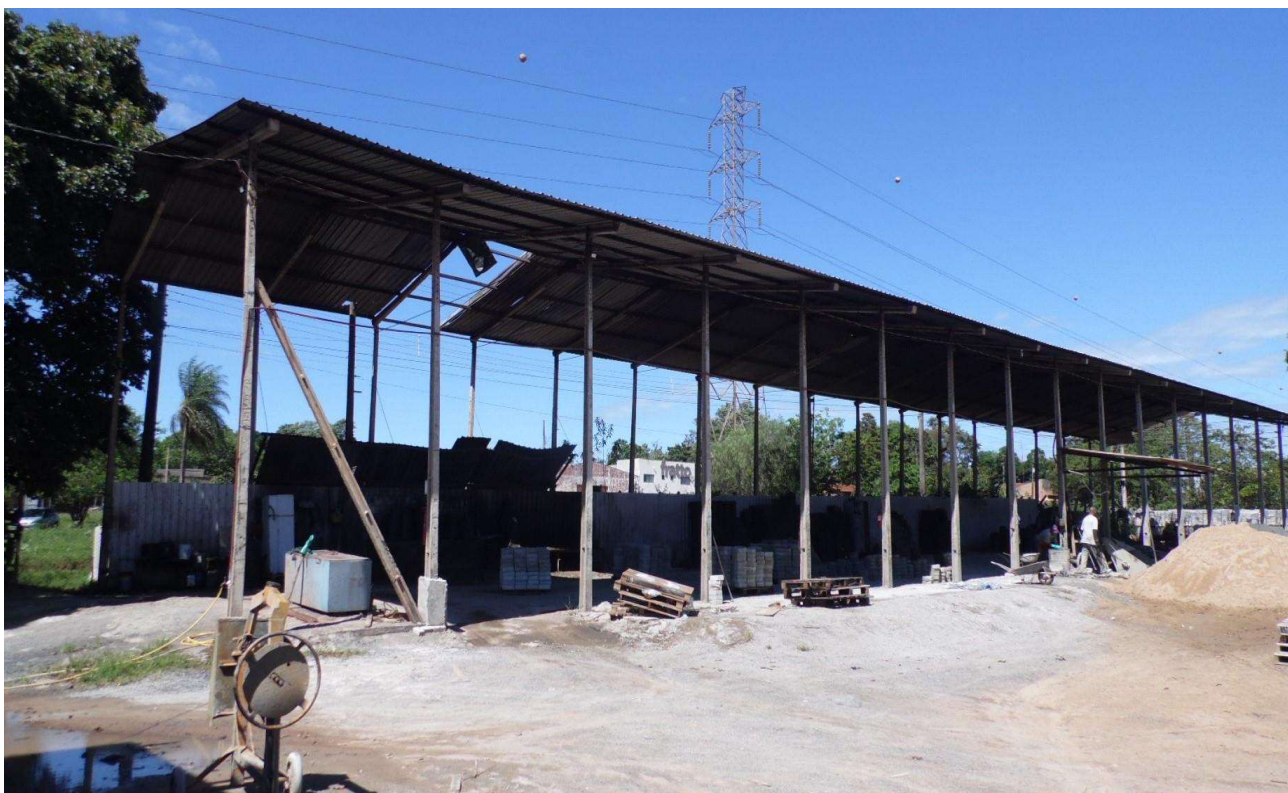
Imagem 19 – Cobertura de trabalho - área construída aproximada de 300.00 m2, construção antiga e negligenciada em relação a conservação/manutenção, valor de mercado reduzido.
