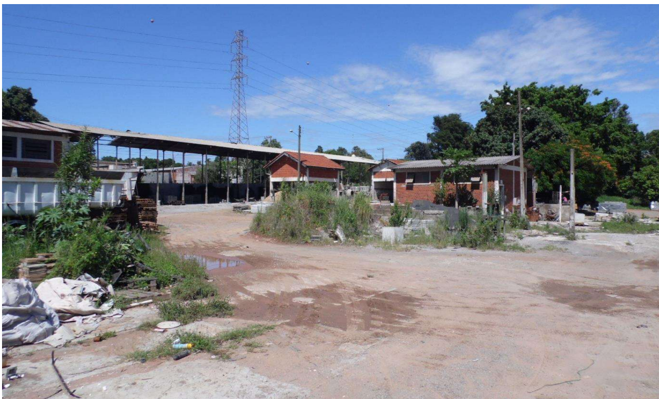
Imagem 06 – Uma das Empresas instaladas no local é a Empresa do Sr. Maurício Bazoti que fabrica pisos de concreto, a qual está utilizando a maioria dos Galpões/Barracões existentes.
