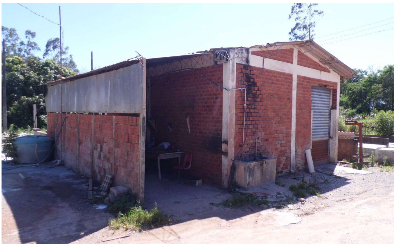
Imagem 16 – Galpão Oficina - área construída aproximada de 60.00 m2, construção antiga e negligenciada em relação a conservação/manutenção, o que reduz o seu valor de mercado.
