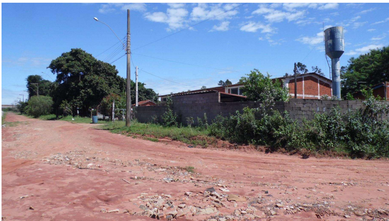
Imagem 02 – Final da Rua da Biotita - infraestrutura precária, não há rede pública da Sabesp, o abastecimento de água é feito por poço semi-artesiano e a captação de esgoto é através de fossa séptica, também não há nenhum tipo de pavimentação e nem galerias de águas pluviais.
