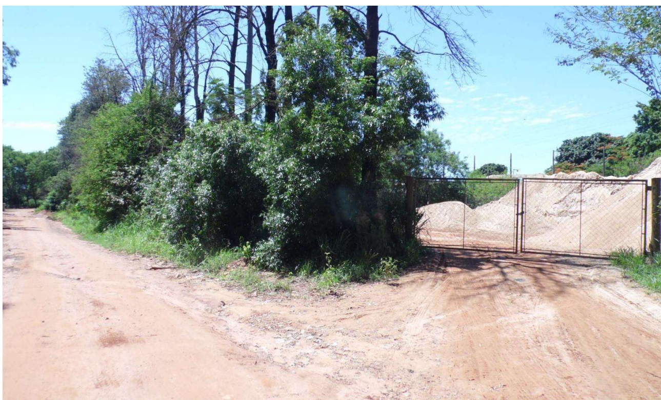
Imagem 04 – Início da área pela Rua da Castanheira no Distrito Industrial de Assis, no local a infraestrutura é precária, sem nenhum tipo de pavimentação e nem galerias de águas pluviais.
