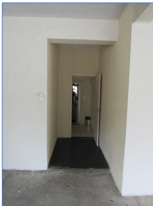
Foto de nº 24- Acesso de serviço ao Edifício Coral Gables – Bloco “B”.
