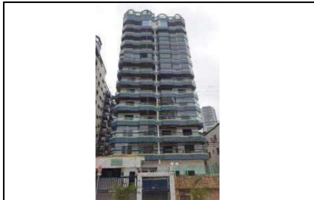
Vista da fachda do imóvel avaliando
