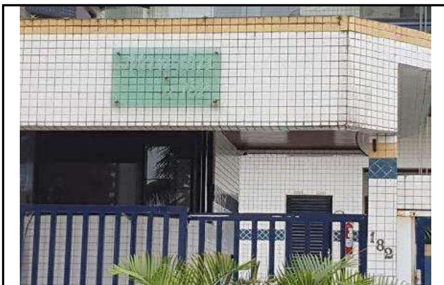
Detalhe da numeração e nome do condomínio
