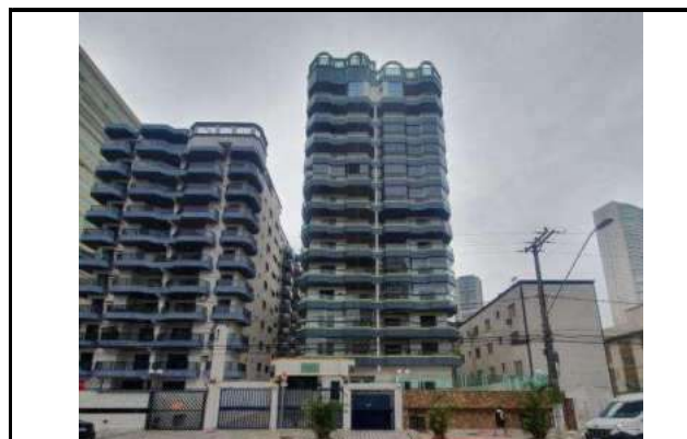
Outra vista da fachada do imóvel avaliando
