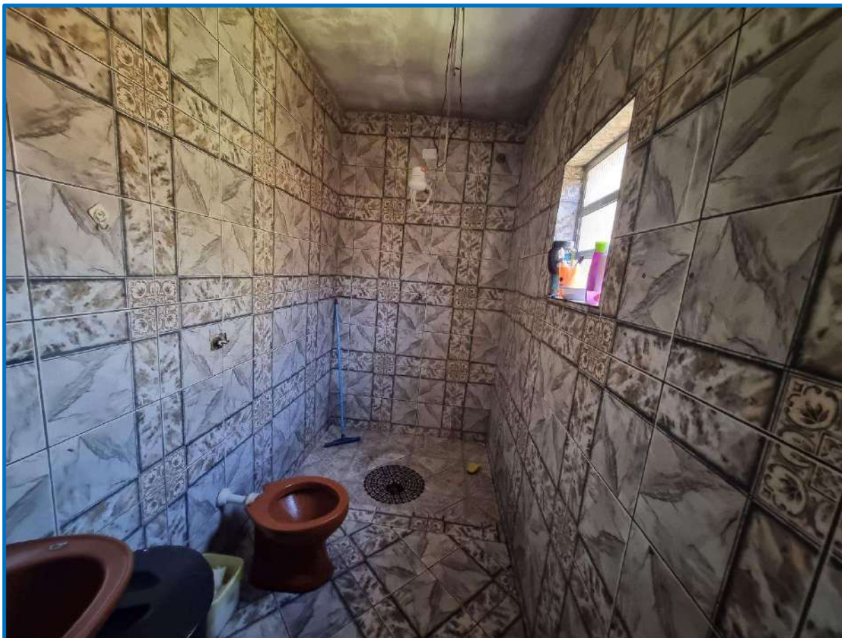
Foto 15 – Vista geral do banheiro do pavimento inferior.
