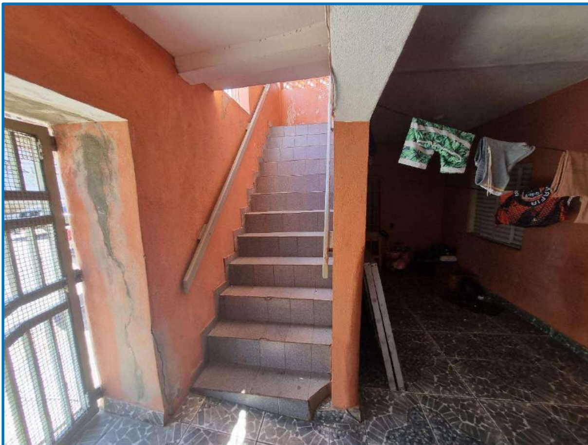
Foto 16 – Vista geral da escada de acesso ao pavimento superior.
