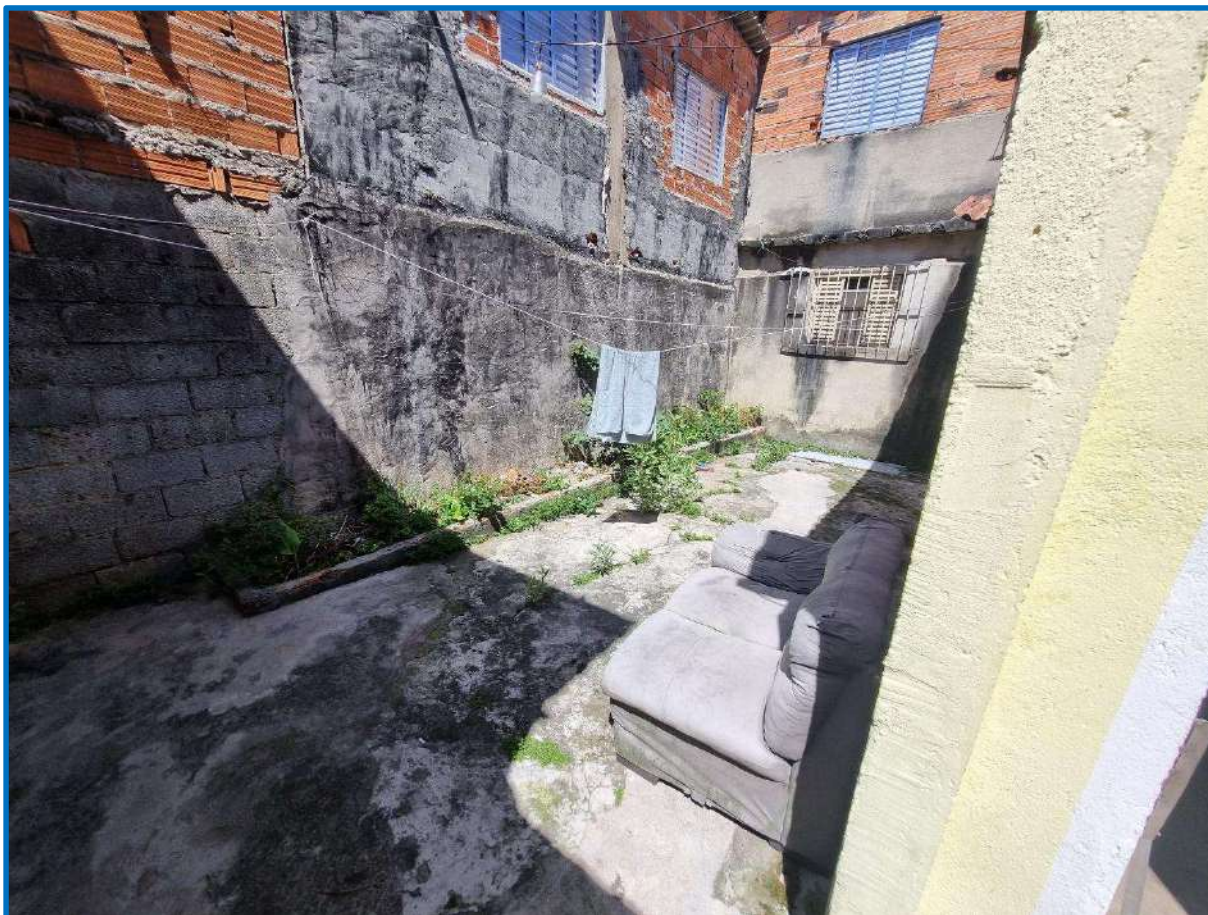
Foto 10 – Vista dos fundos do imóvel, com região de servidão.
