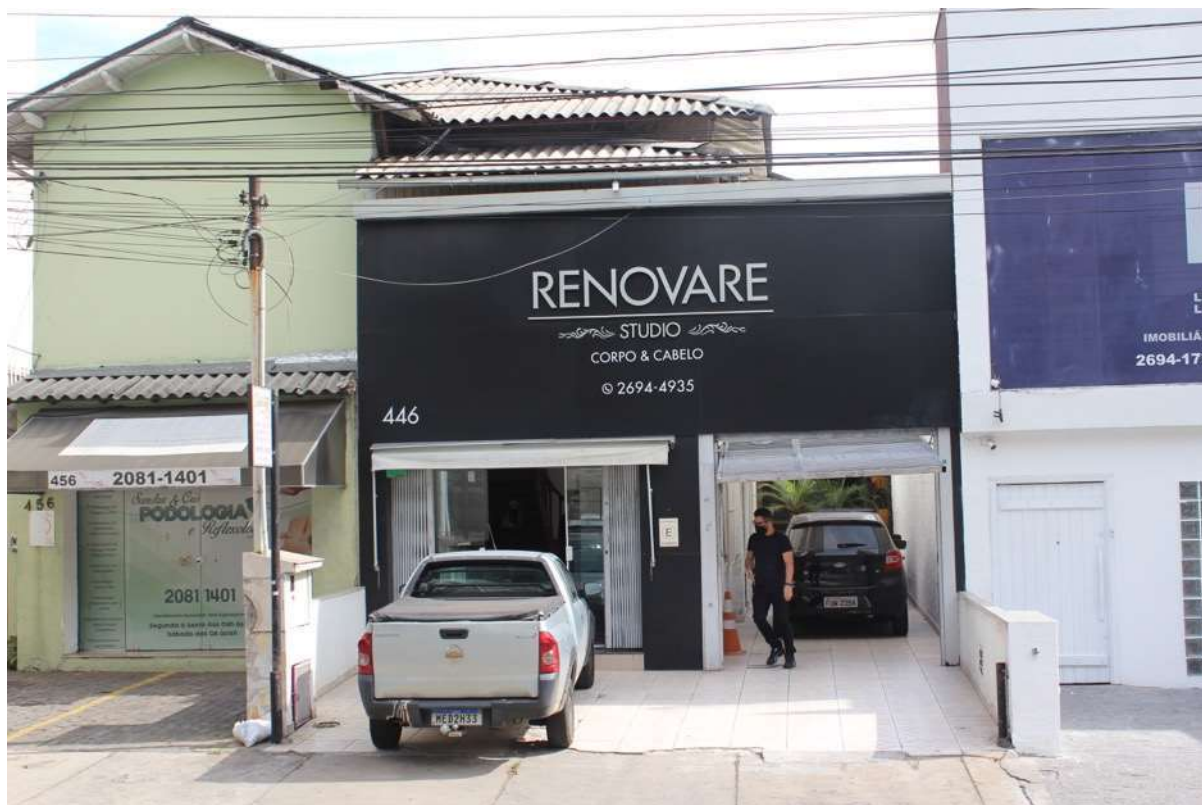
Rua Paes de Barros, 446 (Bairro Mooca) – Fachada Principal do Objeto Pericial
