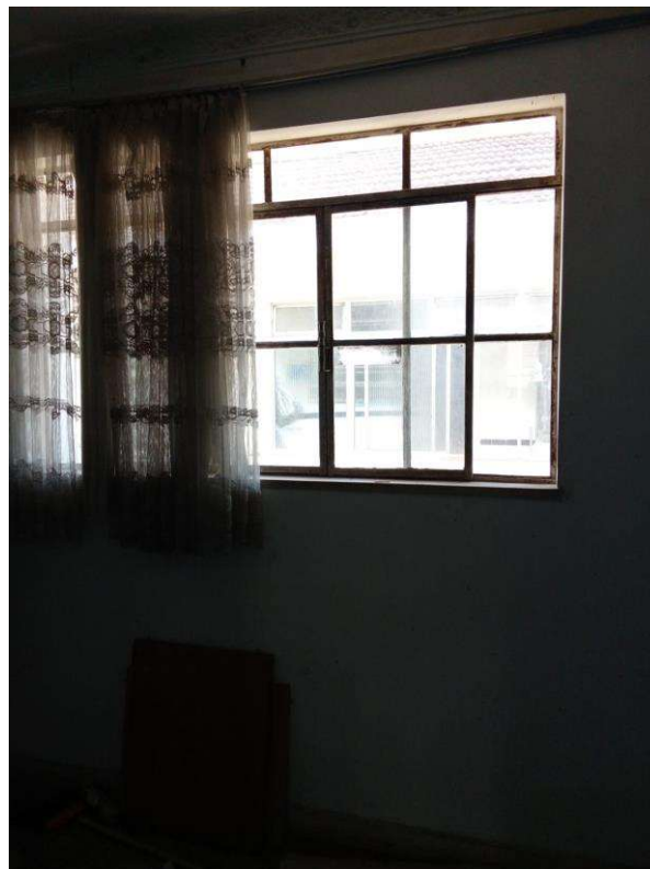
Janela de ferro da Sala com Vidros Transparentes
