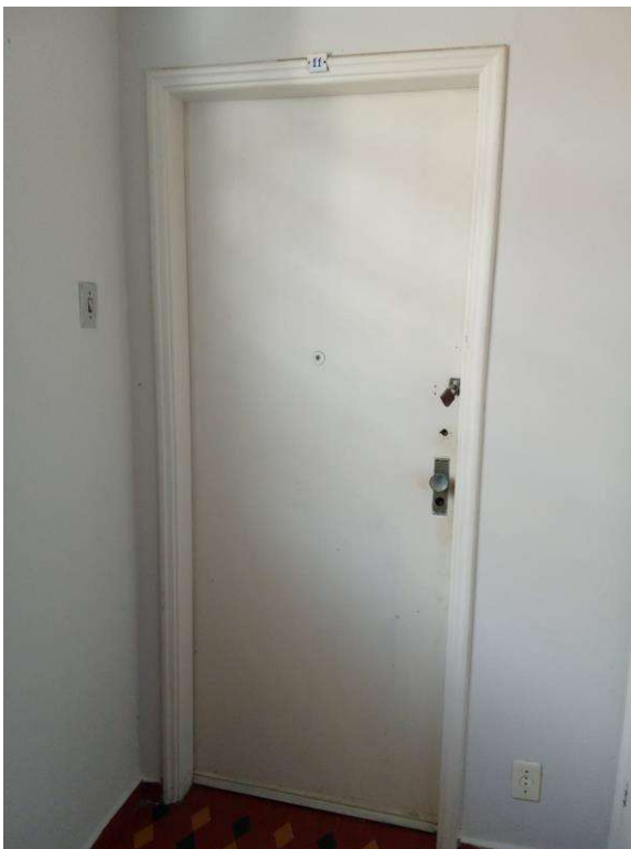
Porta de Acesso ao Imóvel que estava encostada
