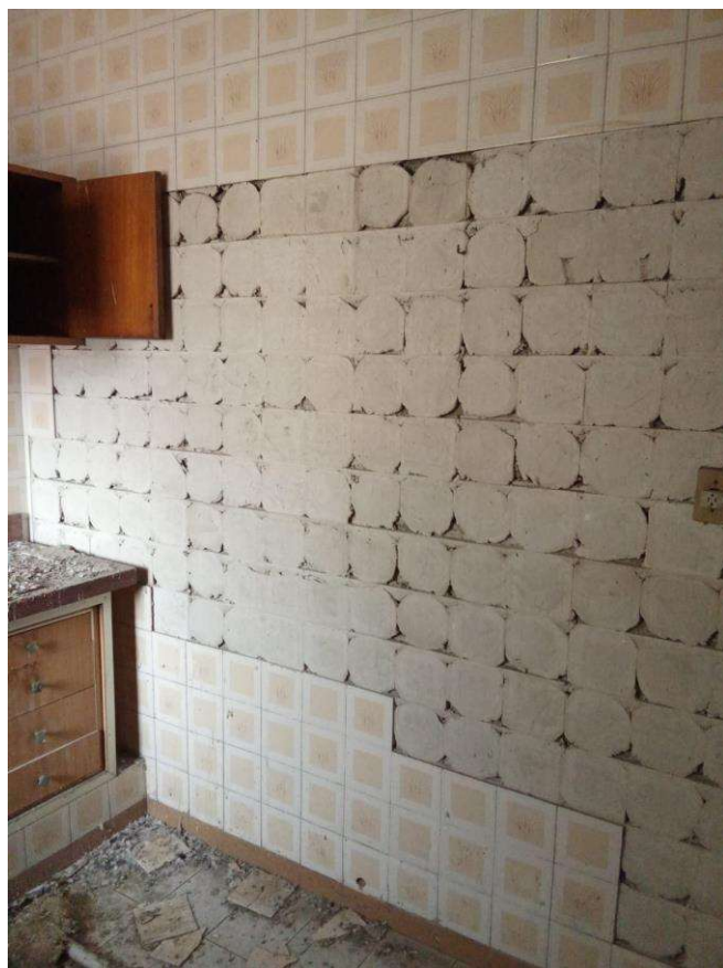
Vista Lateral da Cozinha sem Azulejos
