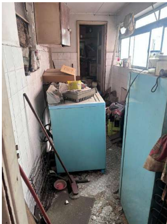
Foto 15: Area de serviço
