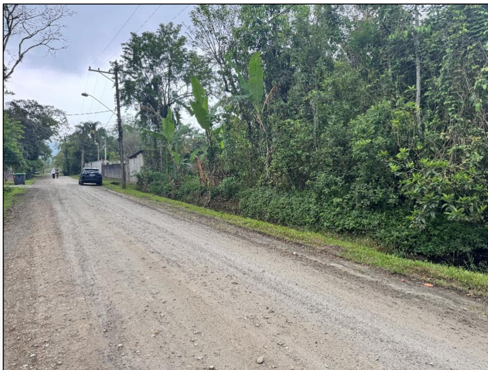
Foto 5 - Vista para a Rua Caramuru do Caruara.
