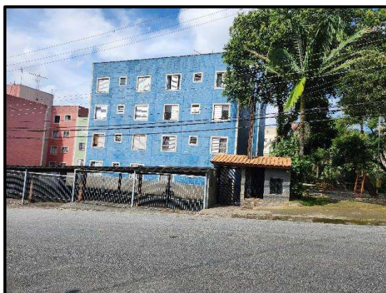
Vista geral do edifício A-17 onde se localiza o imóvel
