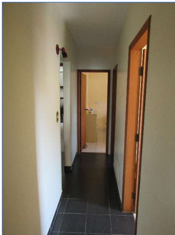
OUTRA VISTA DA CIRCULAÇÃO.
