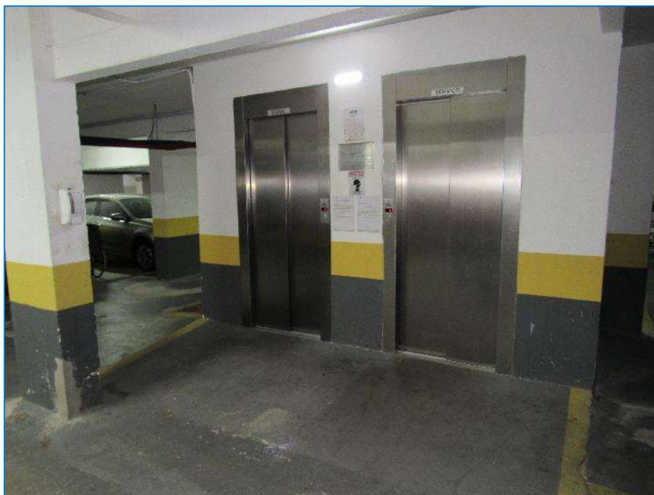
VAGA DESTINADA AO APTO. Nº 211 E HALL DOS ELEVADORES.
