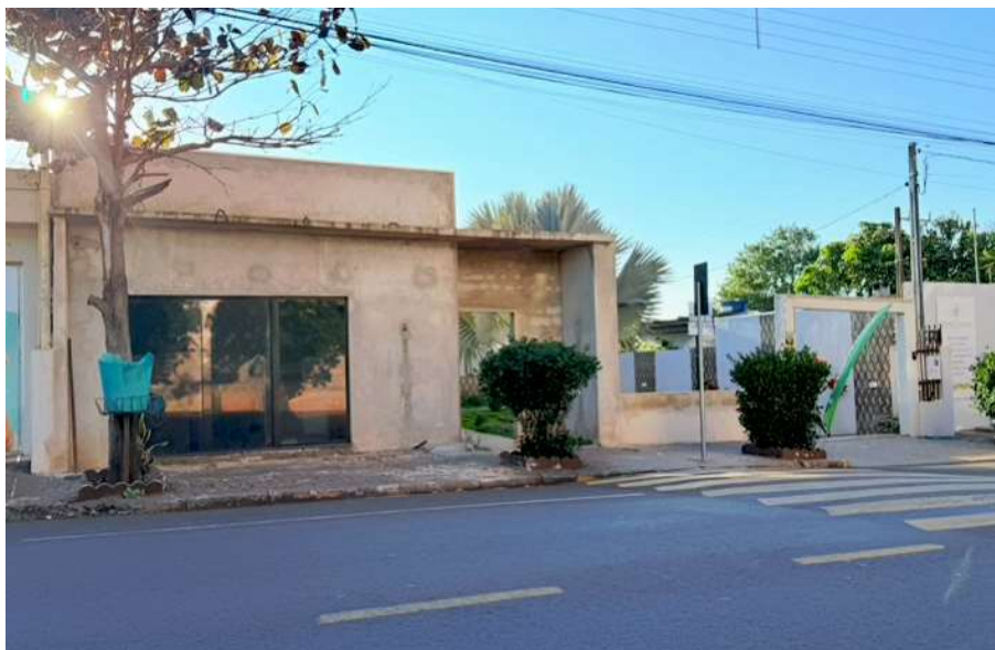
A CASA FICA NOS FUNDOS, NA FRENTE POSSUI UMA PEQUENA SALA COMERCIAL INACABADA.
