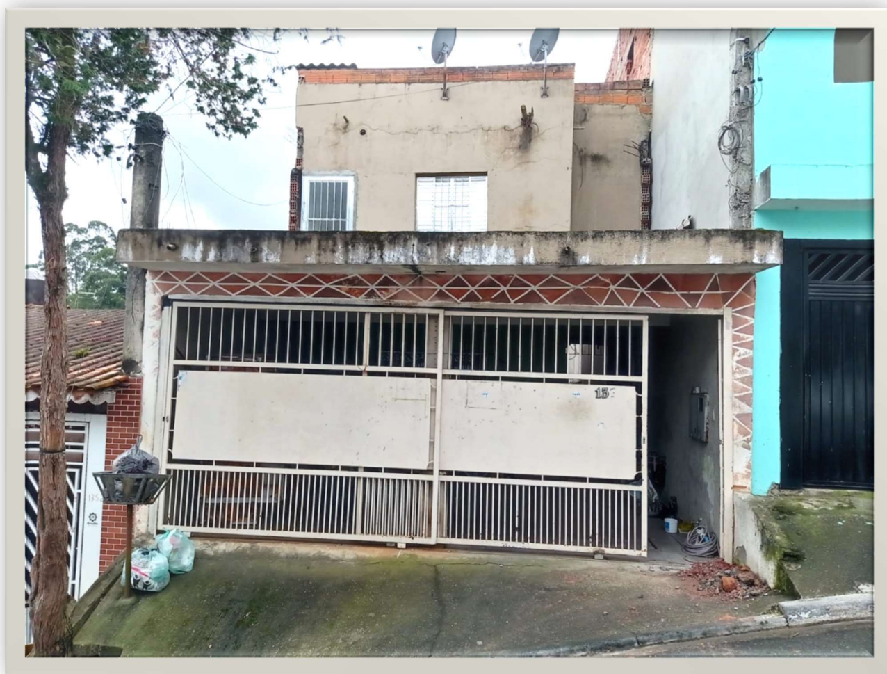
Fachada frontal do imóvel avaliando.
