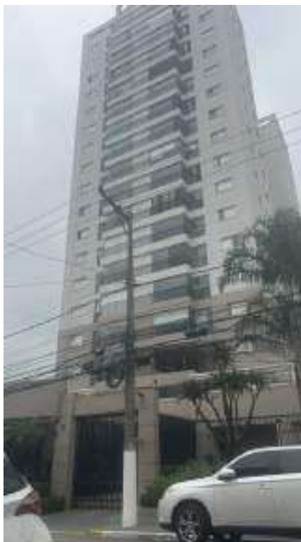
FOTO 01 - FACHADA DO IMÓVEL
