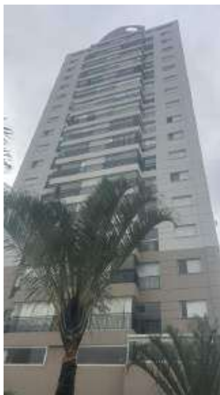
FOTO 36 - VISTA DA FACHADA DOS FUNDOS
